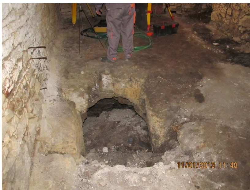
Obr. 1.7 zasypané 2. podzemní patro
