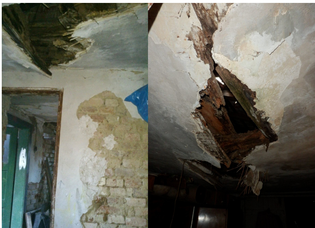
Foto č. 6: Vzorek č. 3; pohled C – druhá (novější) část maštale se silně narušenou stropní konstrukcí („Foto Sandra Studená“)
