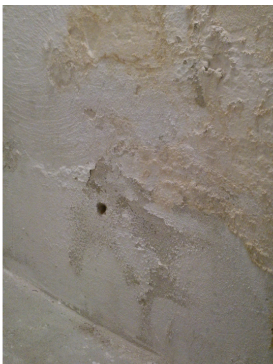
Foto č. 8: Vzorek č. 8; pohled E – Místnost pod schodištěm („Foto Sandra Studená“)
