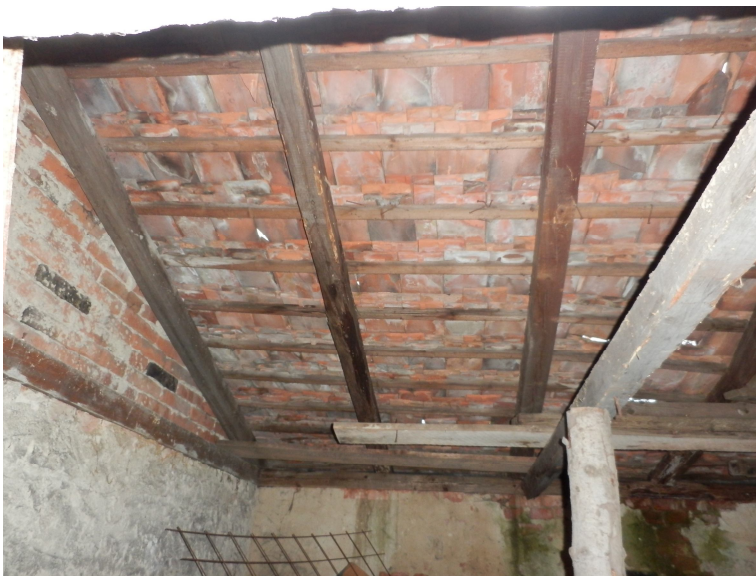
Foto č. 13: Střešní krytina v novější části maštali („Foto Sandra Studená“)
