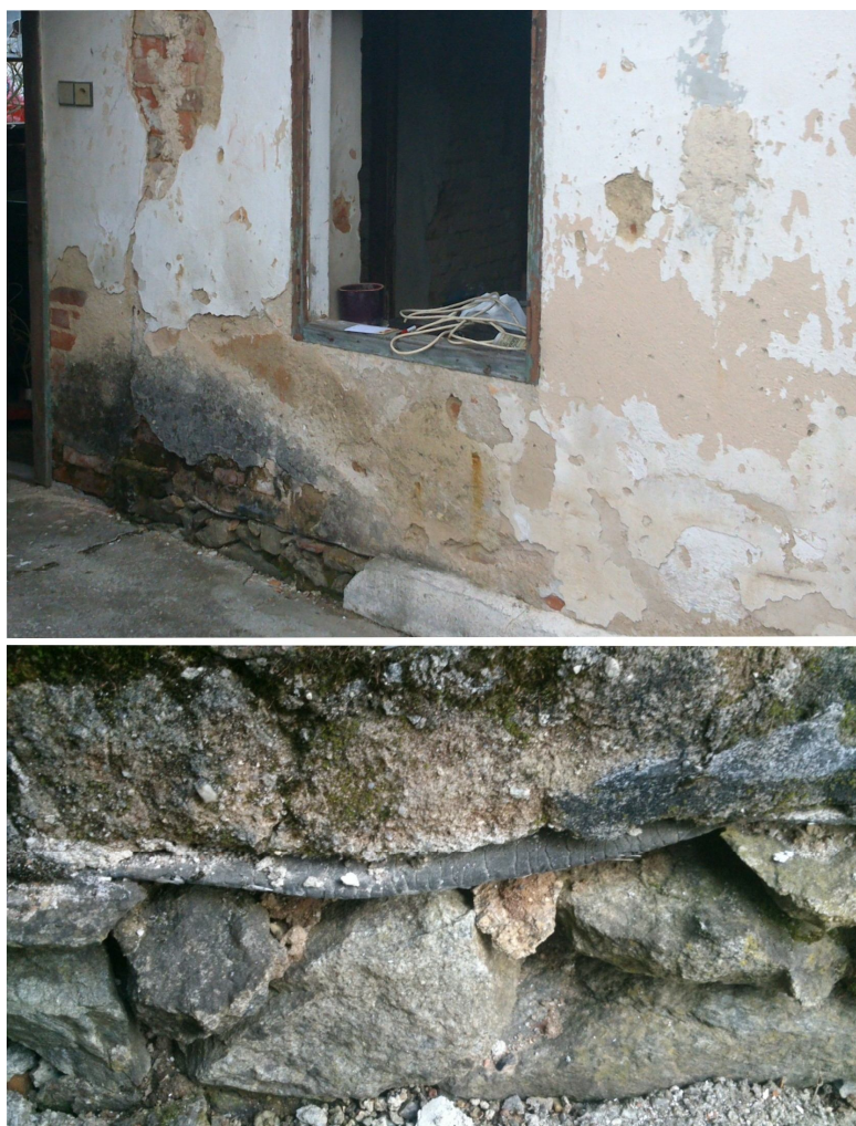
Foto č. 11: Maštal s viditelnou starou asfaltovou hydroizolací („Foto Sandra Studená“)
