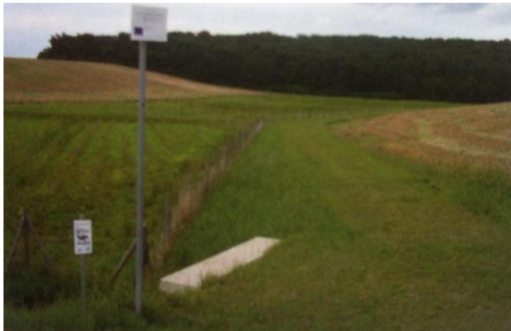
Obr. 16: Ochranná hrázka, (VÚMOP).
