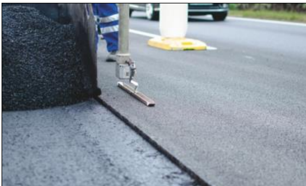
Obrázek 1 Pokládání protihlukového asfaltového povrchu
