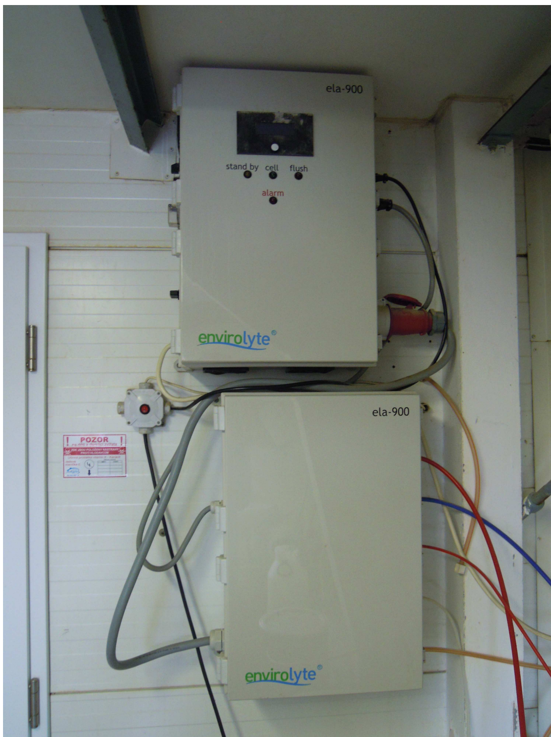
Obr. 8 Zařízení na úpravu napájecí vody EnvirolYTE ELA-900 (foto: autor)
