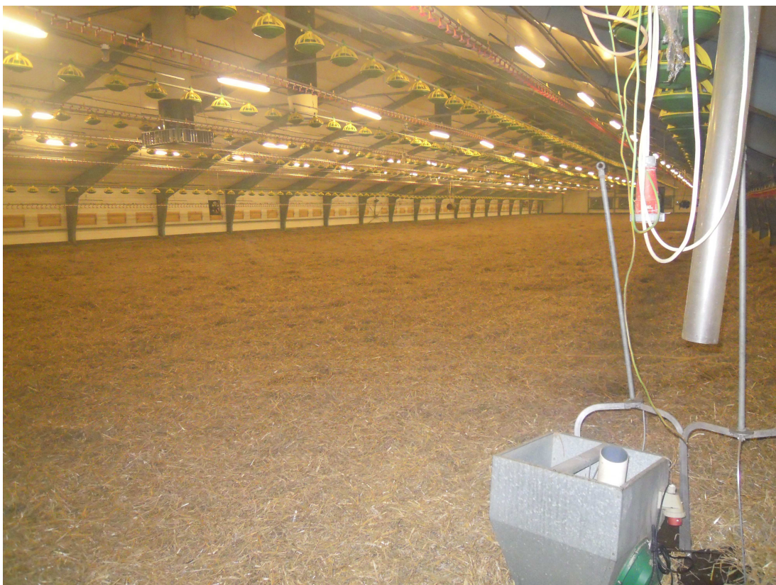
Obr. 2 Pohled na připravenou halu k novému turnusu (foto: autor)
