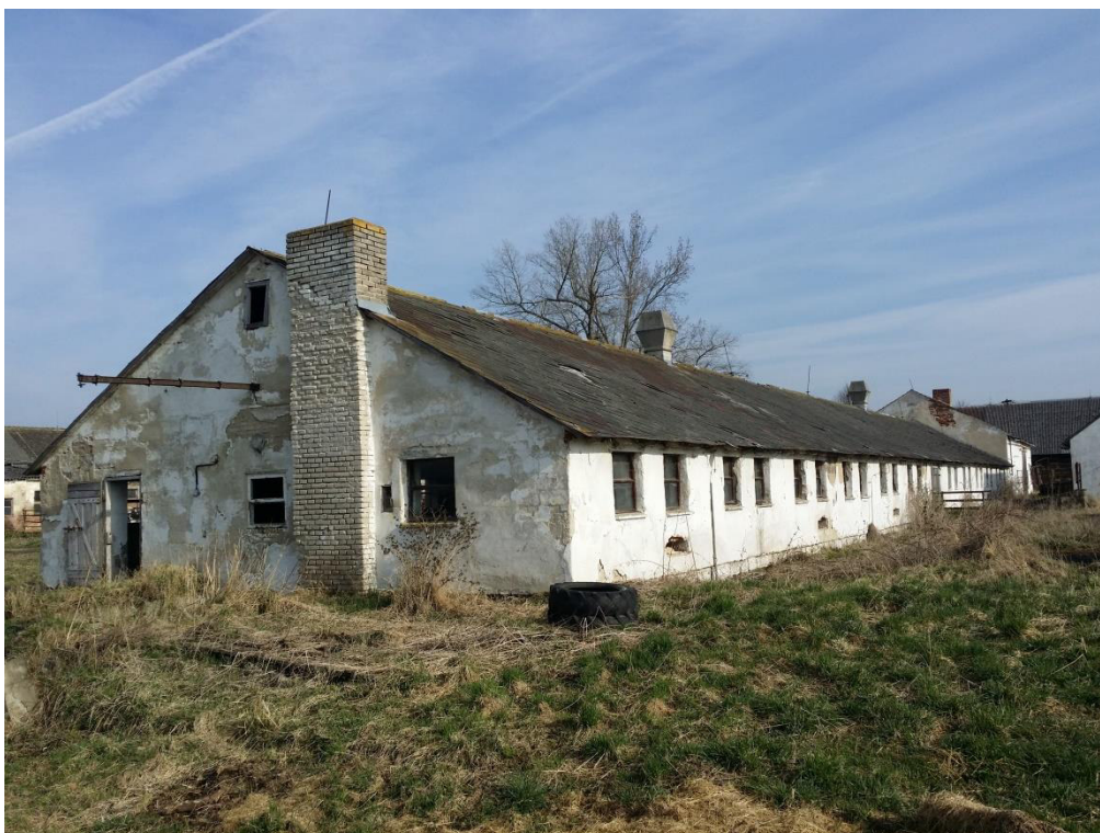
Příloha 5: Fotografie objektu, pohled z jihovýchodní strany
