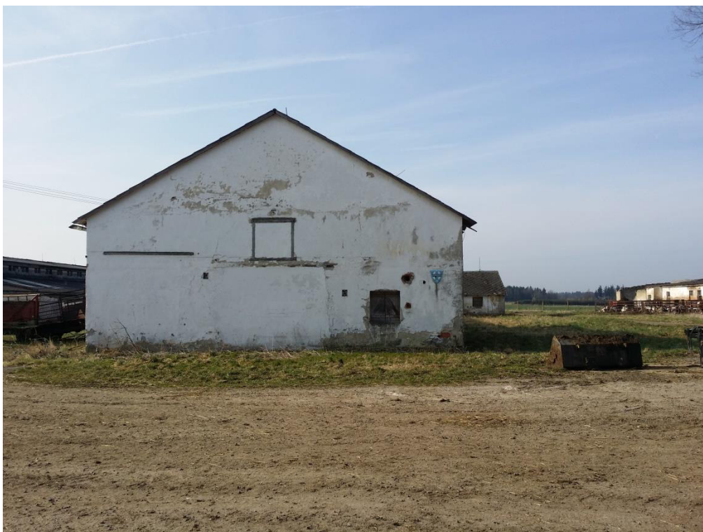
Příloha 1: Fotografie objektu, pohled ze severní strany
