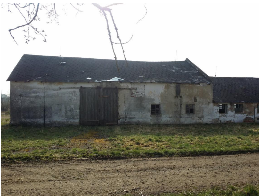
Příloha 2: Fotografie objektu, pohled na sklad ze západní strany
