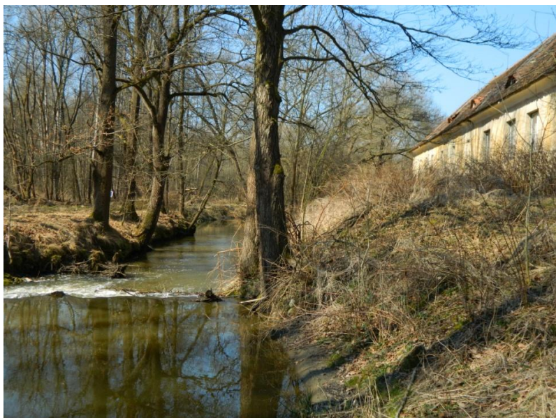
Obr. č. 6: pohled na objekt od bývalého náhonového koryta
