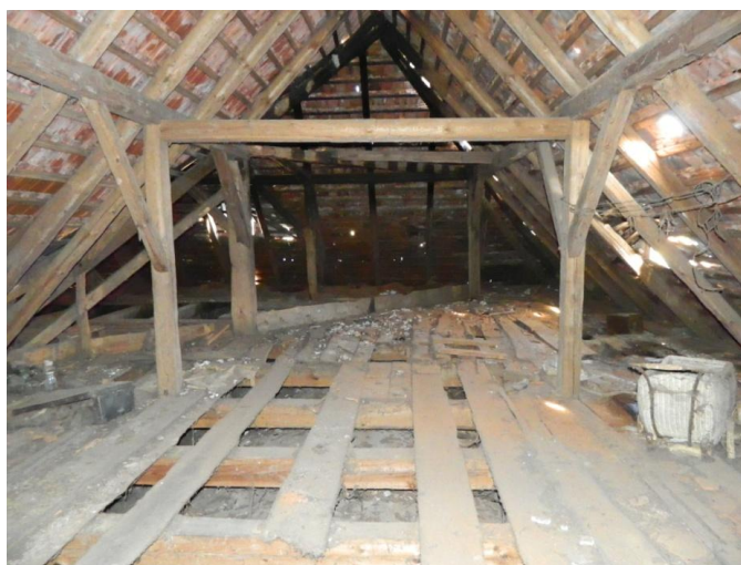
Obr. č. 13: Původní část krovu
