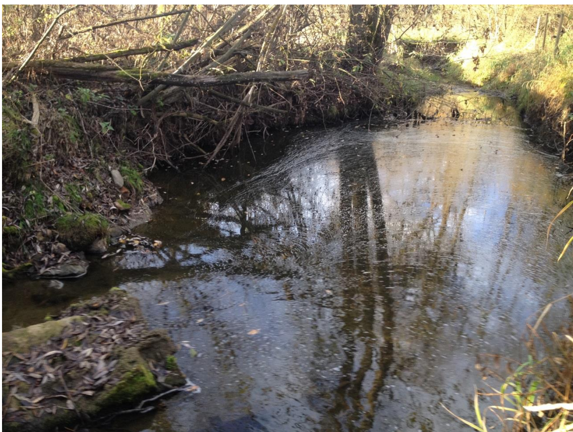
Foto č. 6 – Dobečovský potok, poškozený úsek povodněmi, foto: David Neubauer
