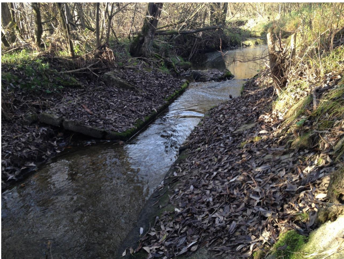
Foto č. 5 – Dobečovský potok, poškozený úsek povodněmi, foto: David Neubauer
