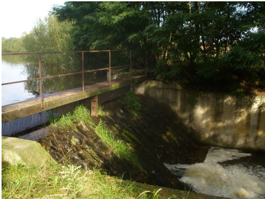
Obr. č. 8 Výpusť z rybníka Posměch (zpracování vlastní)
