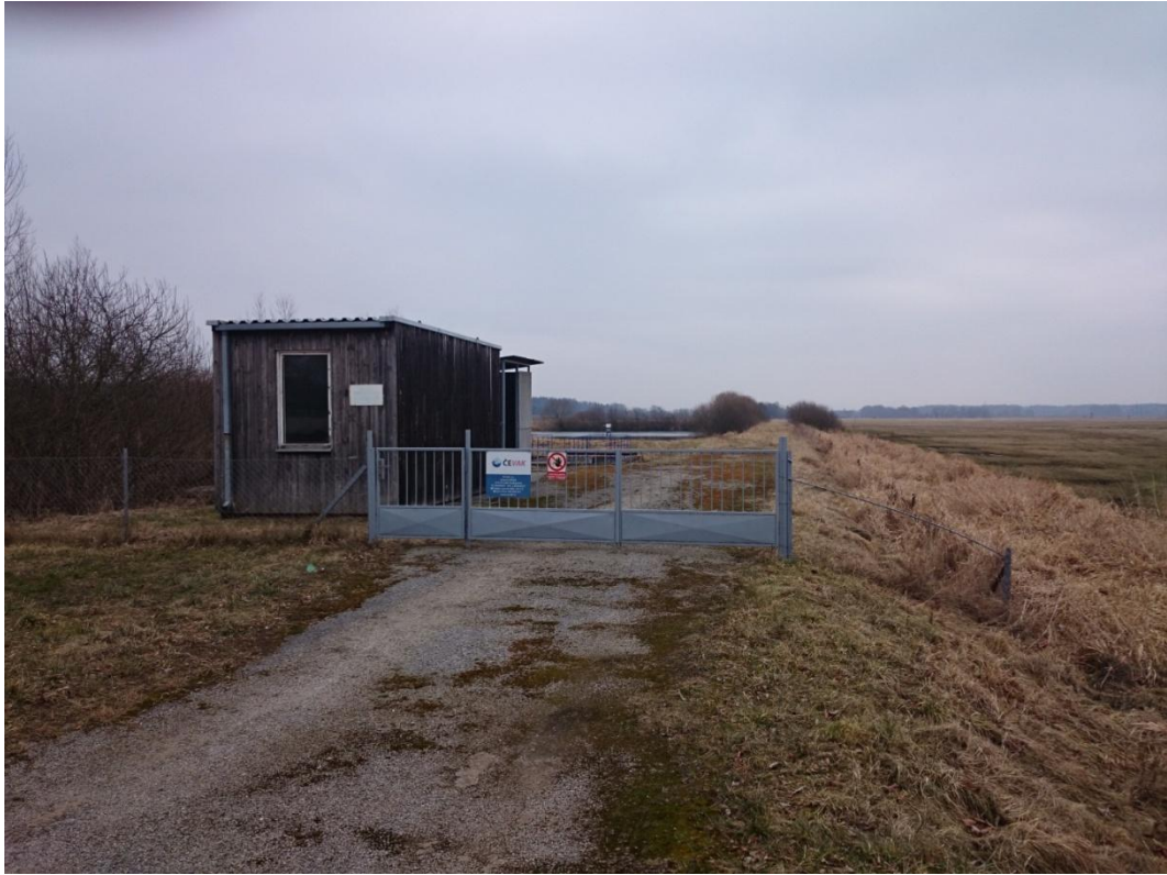
Příloha 11: Čistírna odpadních vod
