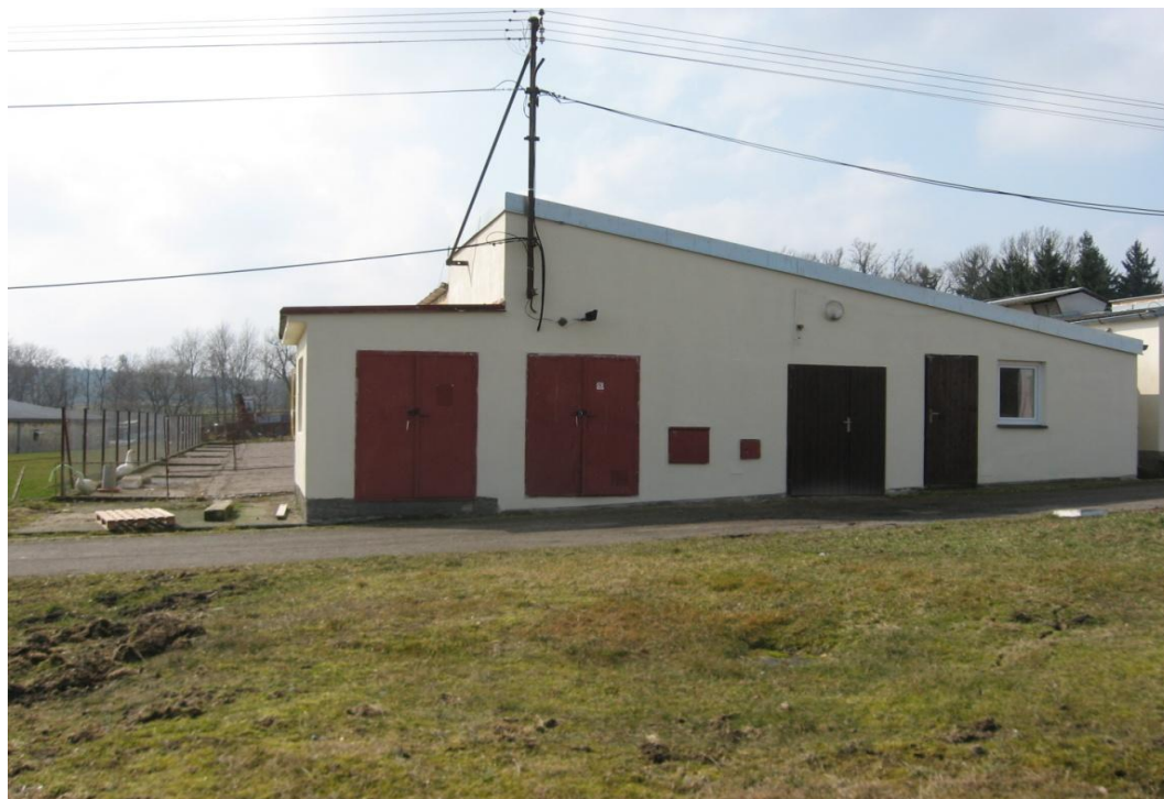
Obr. č. 1 - Stávající stavba- jihovýchodní pohled
