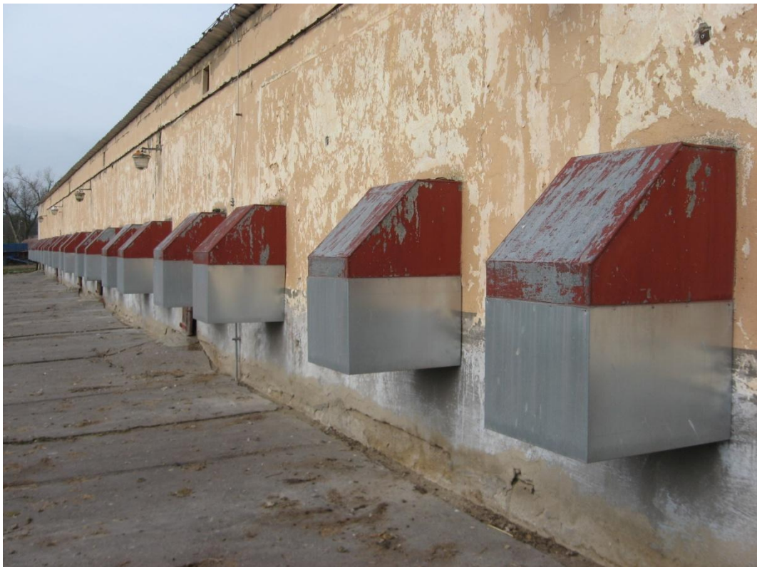
Obr. č. 10 - Kryty větracích klapek vně objektu (rušené) (Zdroj: vlastní šetření)
