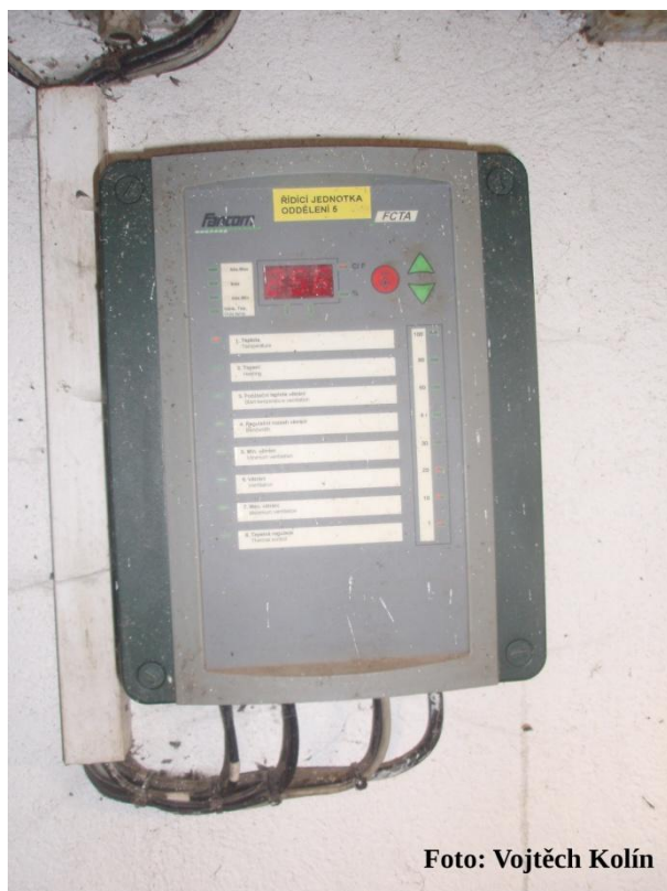
Obr. /foto/ č. 7: Ovládací panel pro nastavení teploty v hale
