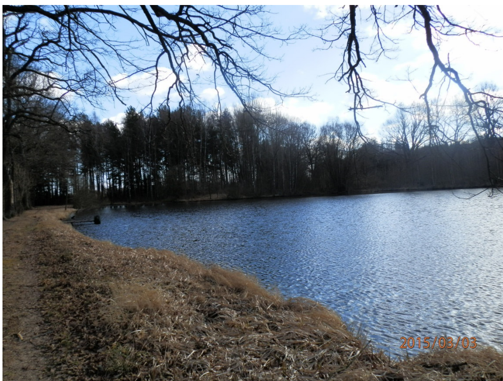
Foto č. 7: Nádrž č. 8 (Panoš)
