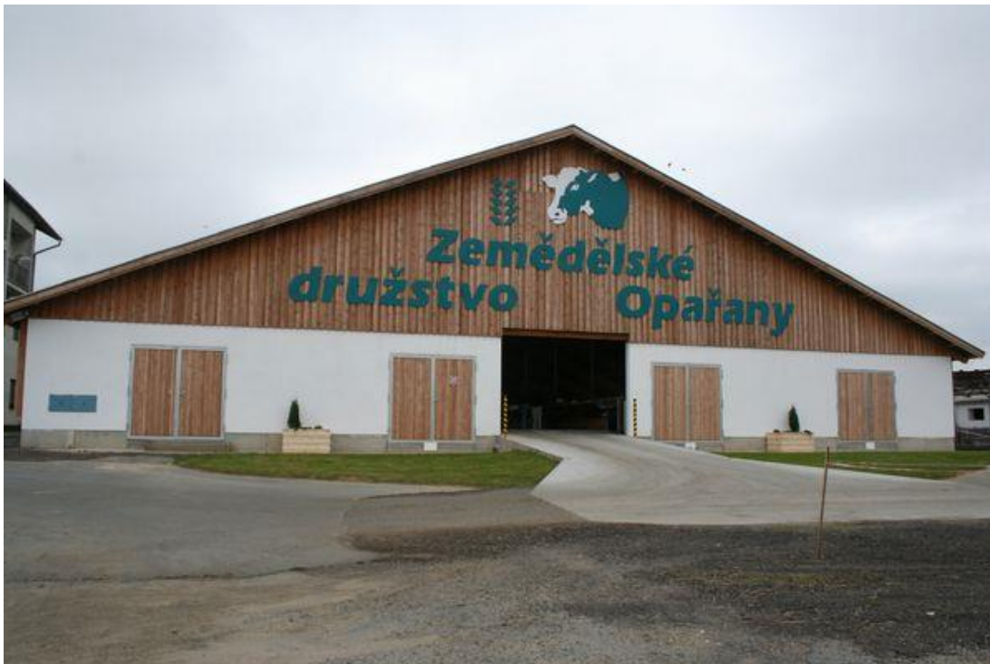
Obrázek č. 2: Zrekonstruovaná stáj pro dojnice
