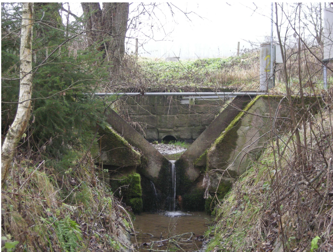
Příloha 5: Uzávěrový profil J2 (Thomsonův přepad)
