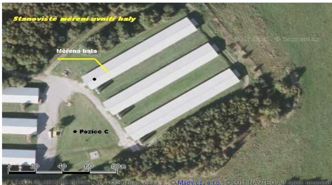
Obrázek 4.4.6 Letecký snímek haly s vyznačeným referenčním bodem měření.
