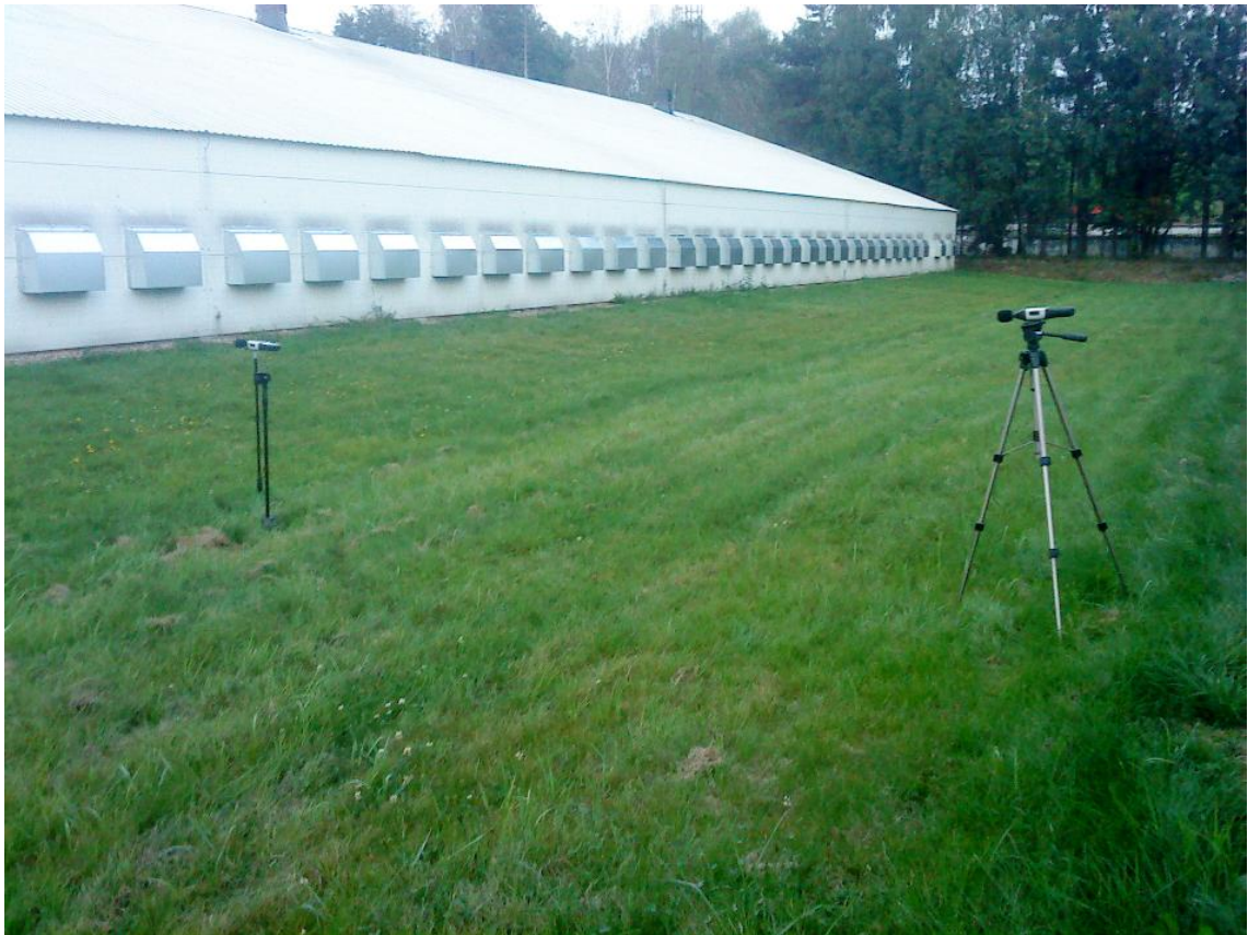
Obrázek 8.1.5 Hala v areálu farmy v Čekanicích s měřicí technikou
