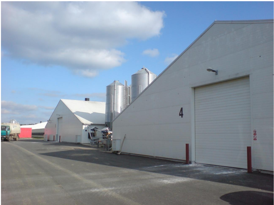
Obrázek 8.1.6 Pohled na měřenou halu na farmě v Čekanicích
