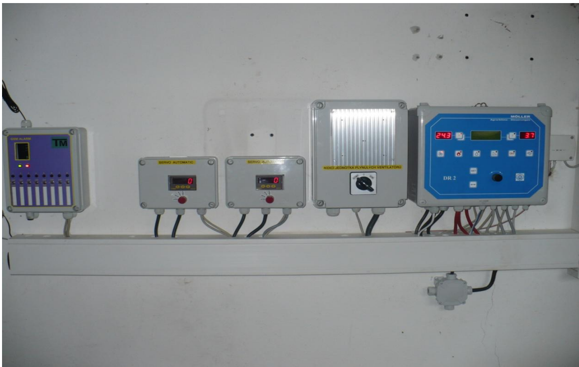
Obrázek 8.1.2 Řídící počítač s GSM terminálem v jedné z hal v Záhorkově
