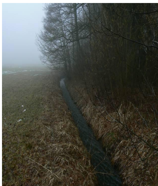
Obr. č. 31: Upravené koryto Rosičky stavbou betonovými dlaždicemi zdroj: vlastní foto
