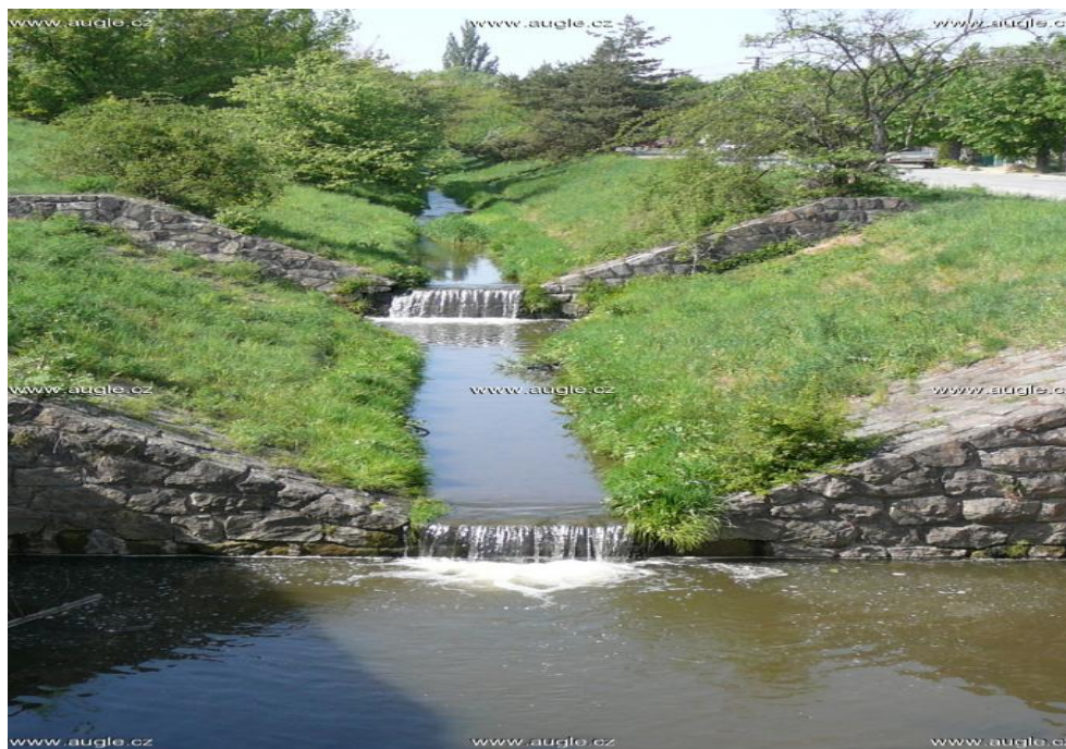
Obr. č. 5: Příčné objekty v korytě drobného vodního toku v rámci revitalizace zdroj: www.augle.cz
