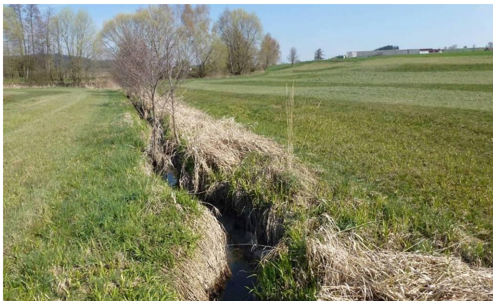
Obr. č. 9: Vodní tok v k. ú. Kamenný Malíkov upravený stavbou s mladým břehovým porostem zdroj: vlastní foto
