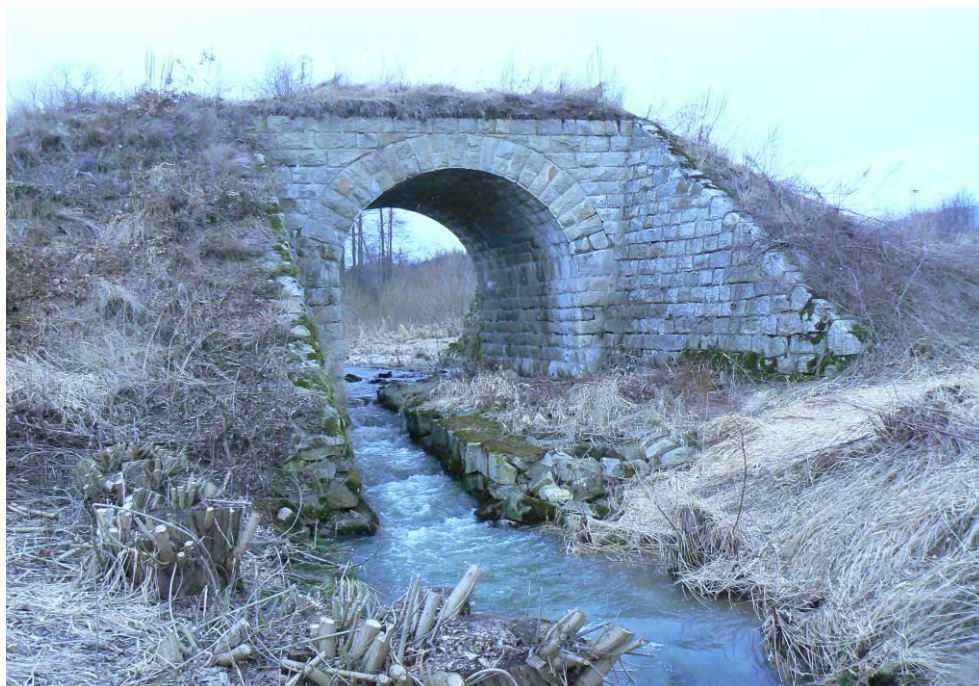
Obr. č. 48: úsek č. 2 zdroj: vlastní foto
