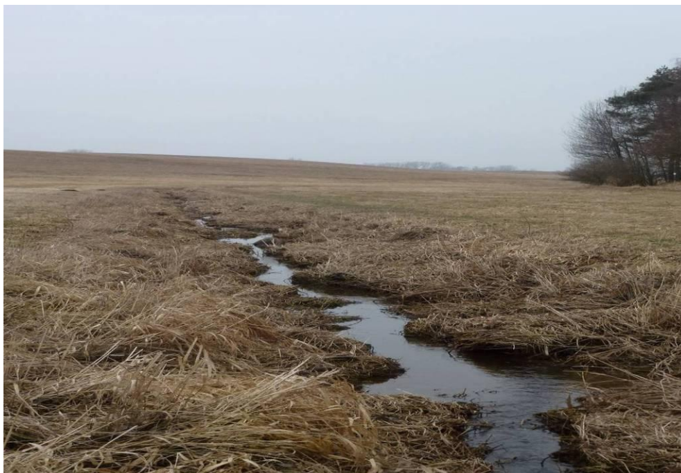
Obr. č. 8: Probíhající renaturace na Kardašském potoce v k. ú. K. Řečice zdroj: vlastní foto
