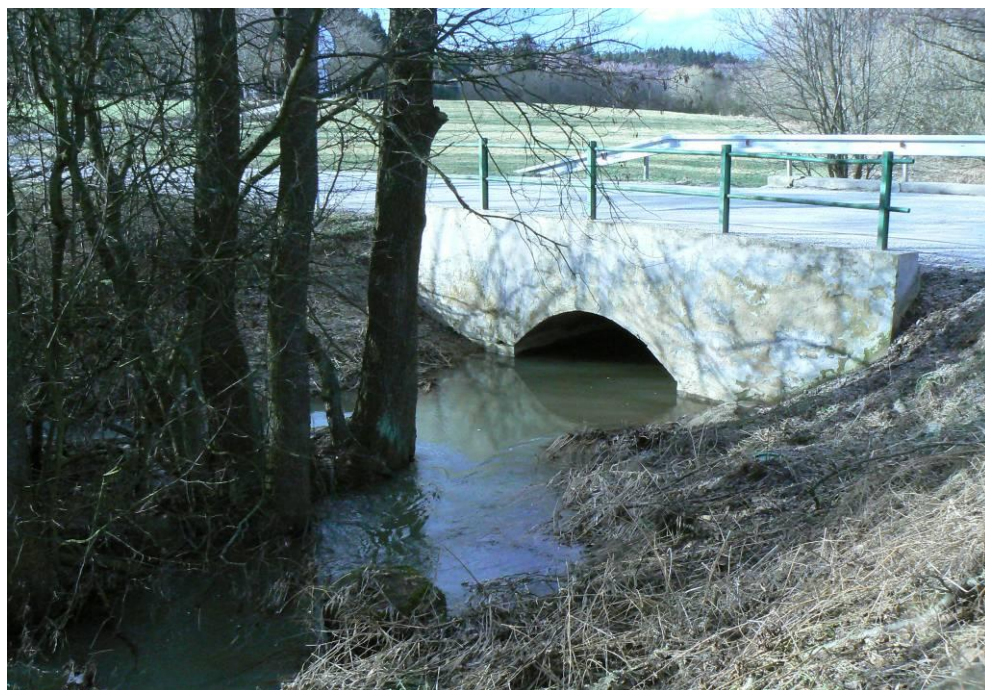
Obr. č. 50: úsek č. 3 zdroj: vlastní foto
