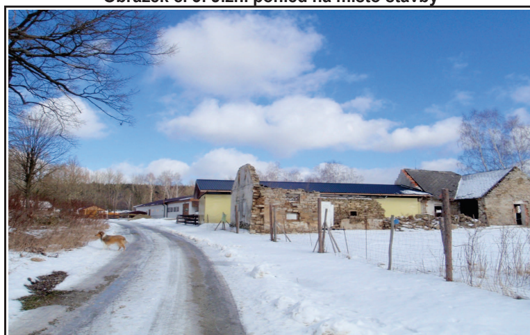
Obrázek č. 3: Jižní pohled na místo stavby
