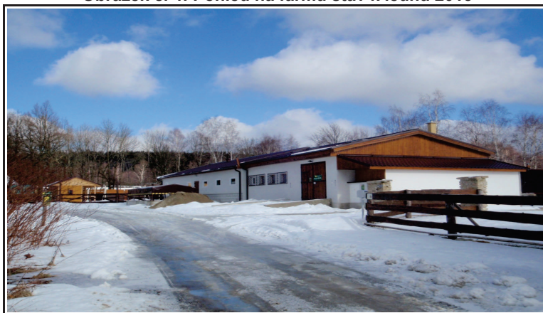
Obrázek č. 4: Pohled na farmu stav k lednu 2013
