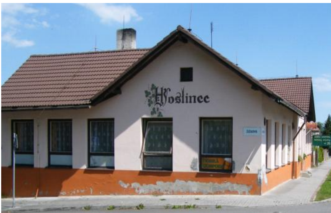
foto 15b, Dnešní pohled na budovu pod nádražím, stále je tam hostinec, který se jmenuje Dobrá Hospoda. Zde je vidět, že se celkový ráz budovy nezměnil až na drobnosti jako např.: okna, střechu a fasádu, 1. 8. 2012. [28]
