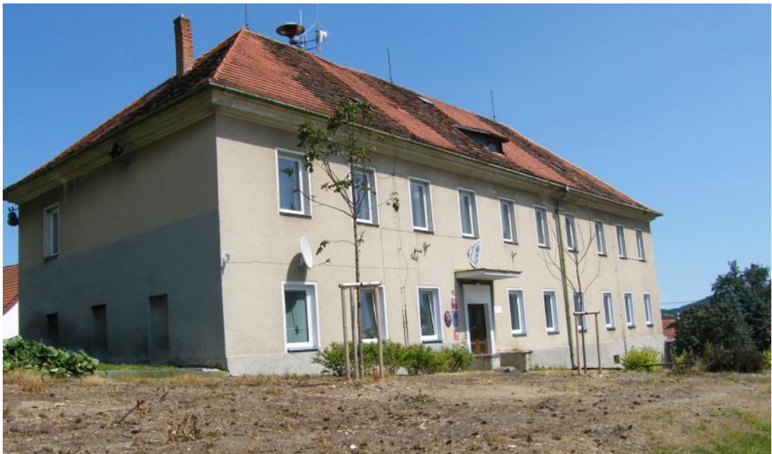
foto 8b, Současný pohled na budovu , kde je nyní Obecní úřad a Kolářova knihovna, 1. 8. 2012. Okolí této budovy se změnilo, došlo k vykácení stromů a vysazení nových stromů. Samotná budova zůstává víceméně stejná až na nějaké drobné úpravy jako např.: výměna oken a výměna střechy. [28]
