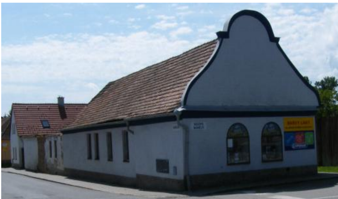
foto 9b, Pohled na bývalou modlitebnu, dnes zde sídlí obchod barvy, laky, 1. 8. 2012. Ráz této budovy a ani okolí se příliš nezměnil až na nepatrné stavební změny jako absence elektrického sloupu, bezpečnostní zrcadlo a ukazatel. [28]
