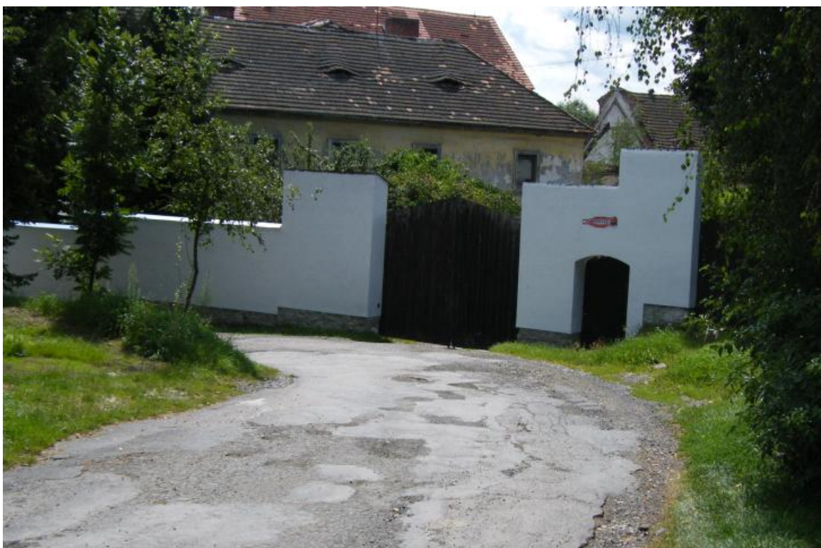
foto 18b, Dnešní pohled na cestu ke mlýnu, 1. 8. 2012. Naopak z této fotografie je patrné, že objekt opět chátrá a příjezdová cesta by si určitě také zasloužila rekonstrukci, protože je to příjezdová cesta do kempu, tudíž je v létě hodně frekventovaná. [28]
