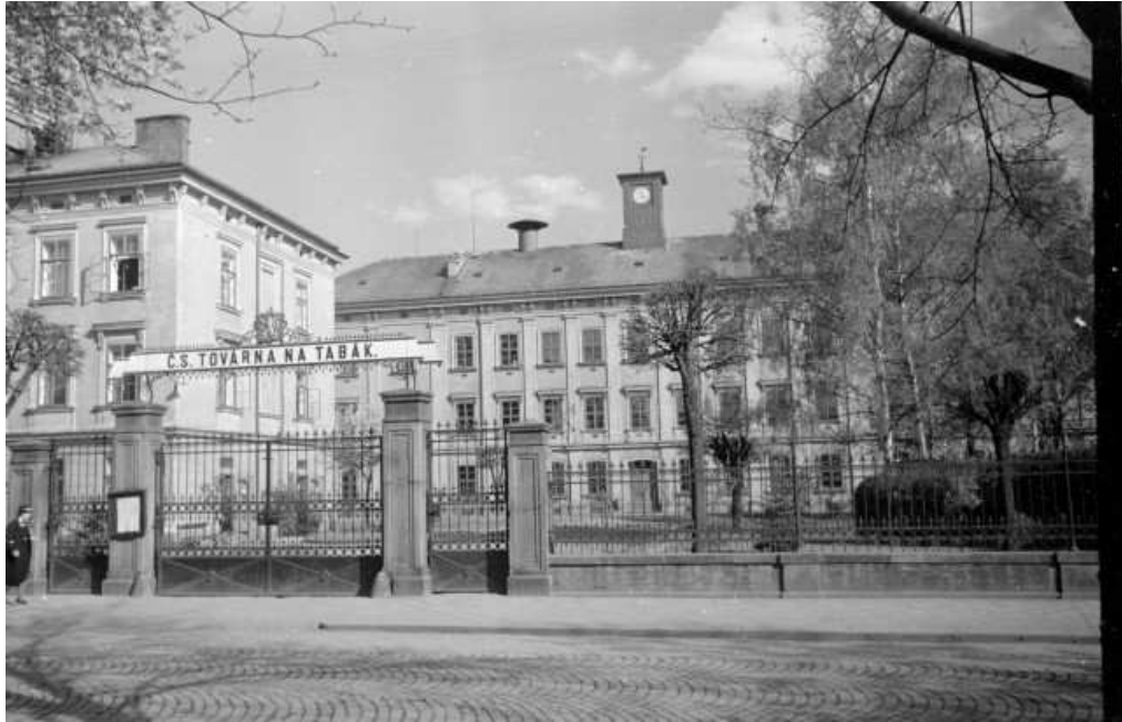
Obrázek č. 12 a: Továrna na tabák kolem roku 1980 mezi místními známá jako „tabačka“. Původně byl celý areál vybudován jako továrna na zpracování tabáku, v době socialismu zde sídlila armáda. V současnosti budovy obývá okresní úřad, lékaři a služby (Šechtl a Voseček)[9].
