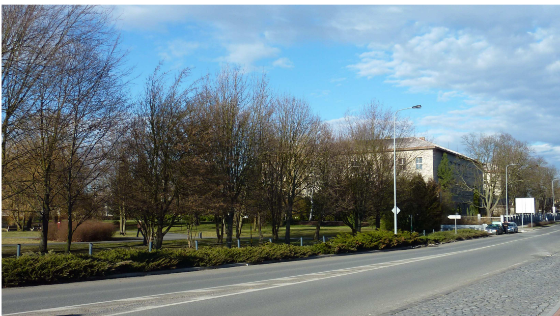
Obrázek č. 9 b: Při dnešním pohledu si rozhodně všimneme vzrostlých stromů v parku U Popraviště, kde se nachází památník obětem 2. světové války. Kdysi hlinitá cesta se změnila v asfaltovou komunikaci, která nese název Kpt. Jaroše. Před lety byla tato část města velice rušná díky vojenské posádce, dnes se postupně mění v obytnou část Tábora (Kášek, 2013).
