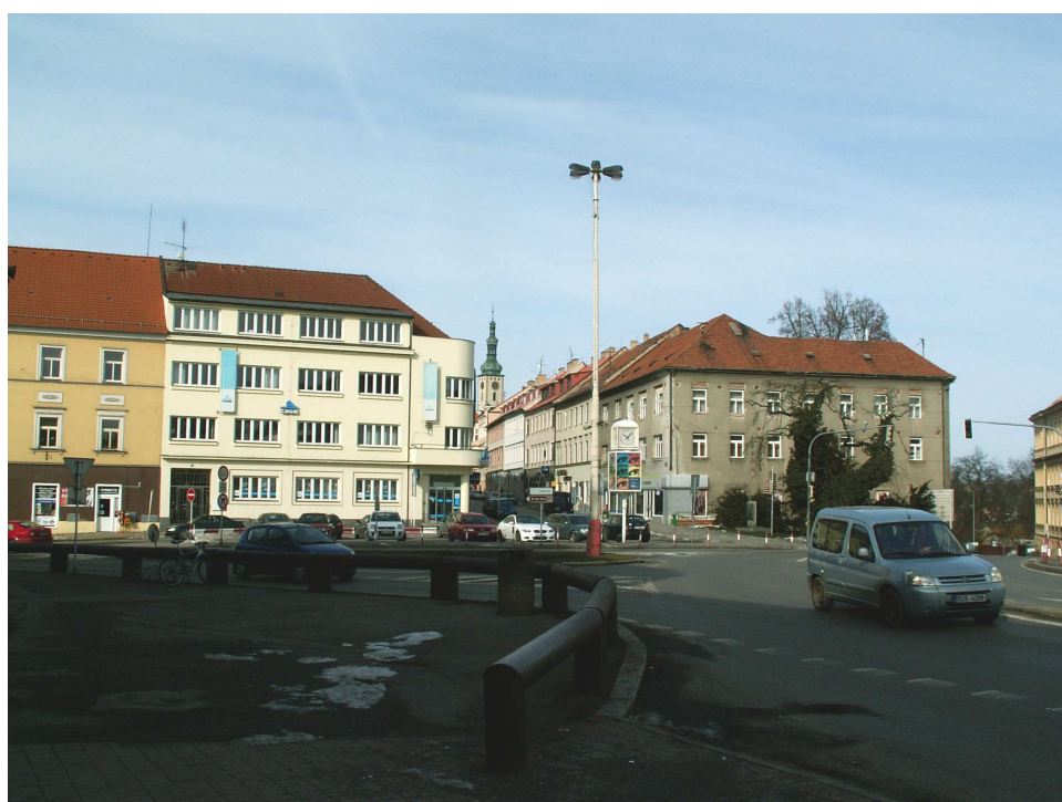
Obrázek č. 20 b: Současný vzhled Křižíkova náměstí těsně před začátkem prací na jeho regeneraci. Kruhovou křižovatku dnes vystřídal parkoviště. Lidský ruch vystřídal spíše ruch silniční, jelikož se jedná o velice frekventovanou městskou křižovatku. Obrázek č. 20 c ukazuje studii budoucího vzhledu náměstí (Kášek, 2013).
