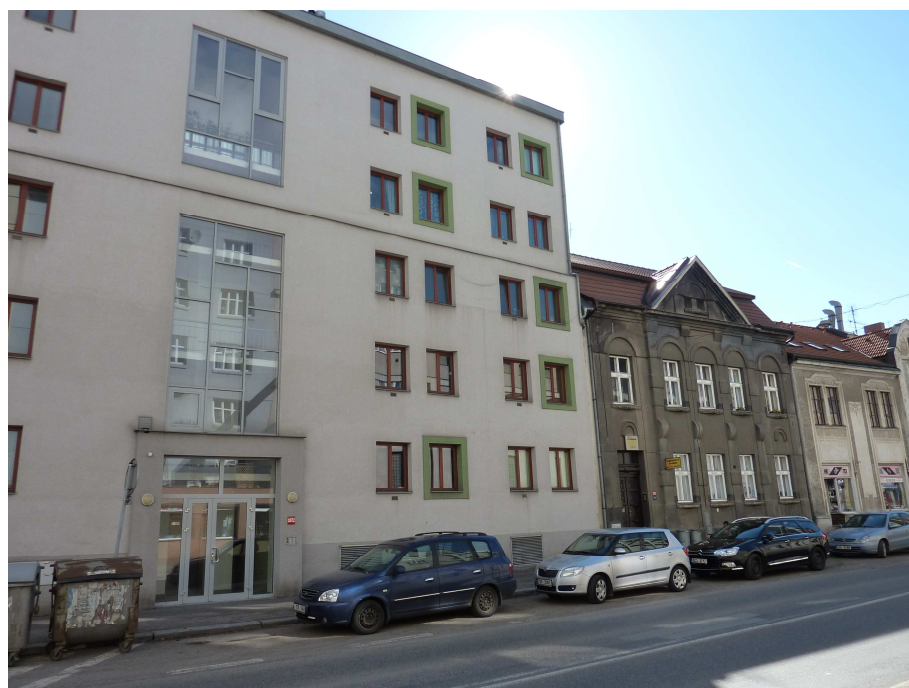
Obrázek č. 1 b: Při pohledu na obrázek je patrný rozdíl v zástavbě. Z historie je patrné, že budova staré kovárny byla zbourána a měla jí nahradit nová obytná budova. Tato stavba se ve své době nerealizovala z důvodu špatného podloží a svažitosti. Až s novými stavebními technikami, zde vyrostl tento obytný komplex (Kášek, 2013).
