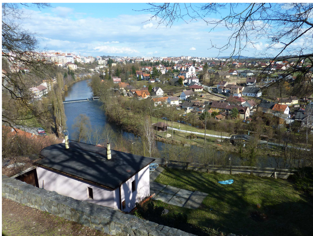
Obrázek č. 6 b: Současné panorama ukazuje vývoj urbanizace a suburbanizace ve městě. Bohužel proti původní fotografii je dnešní výhled narušen množstvím vzrostlých stromů. Pohled přes řeku ukazuje postupně se rozrůstající zástavbu rodinných domů (Kášek, 2013).
