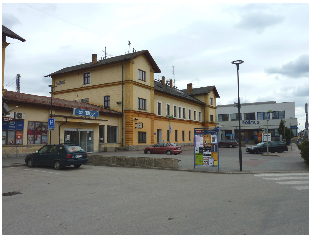
Obrázek č. 13 b: Na obrázku je zachycena budova nádraží. Tato část budovy se kromě oprav a modernizace moc nezměnila. Bohužel před budovou chybí okrasný parčík, který byl nahrazen několika betonovými květináky a hlavně parkovištěm. Dále přibyla budova pošty (Kášek, 2013).
