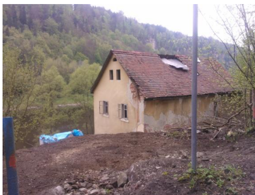
Obrázek 5: Zchátralá budova. Zdroj: Vlastní foto.
