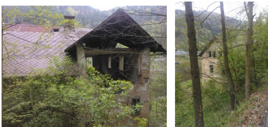
Obrázek 6: Zchátralá budova, dva pohledy. Zdroj: Vlastní foto.
