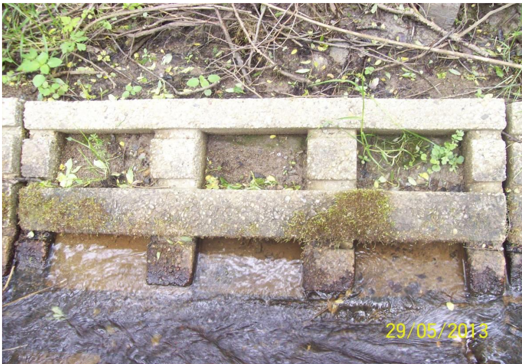
Obr. č. 39 – Polovegetační betonová tvárnice – AUTOR PRÁCE 2013
