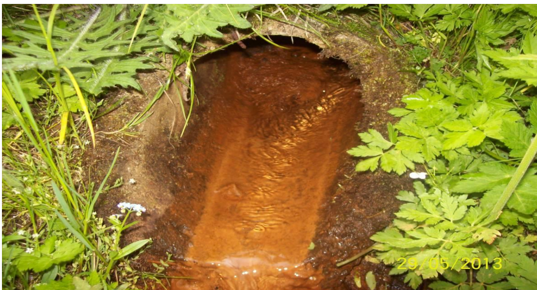
Obr. č. 11 – Drenážní vyústění z trvale travních porostů – AUTOR PRÁCE 2013
