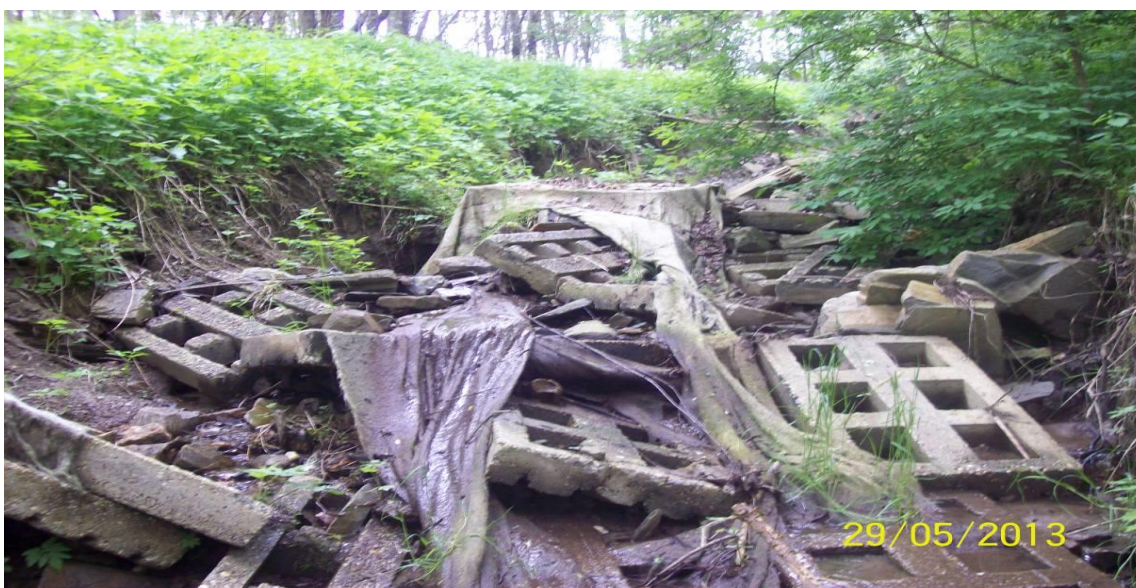
Obr. č. 44 – Splavené tvárnice – přítok č.1 – AUTOR PRÁCE 2013
