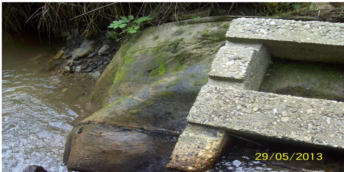
Obr. č. 43 – Geotextýlie s polovegetační tvárnici - AUTOR PRÁCE 2013
