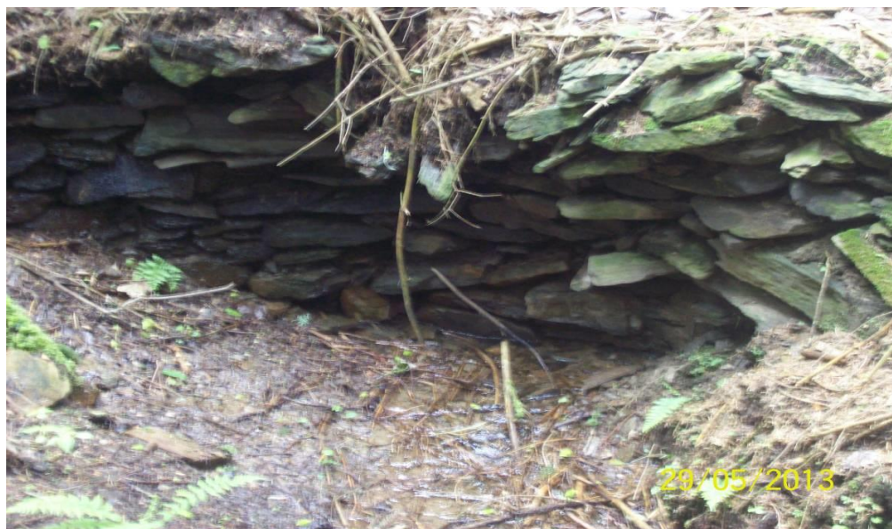
Obr. č. 63 – Prameniště pod silnicí přítoku č.2 - AUTOR PRÁCE 2013
