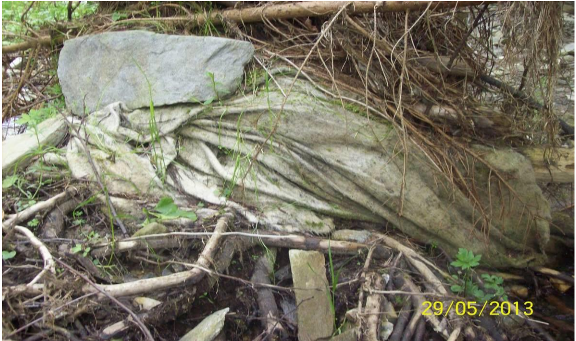
Obr. č. 78 – Splavená geotextýlie - AUTOR PRÁCE 2013
