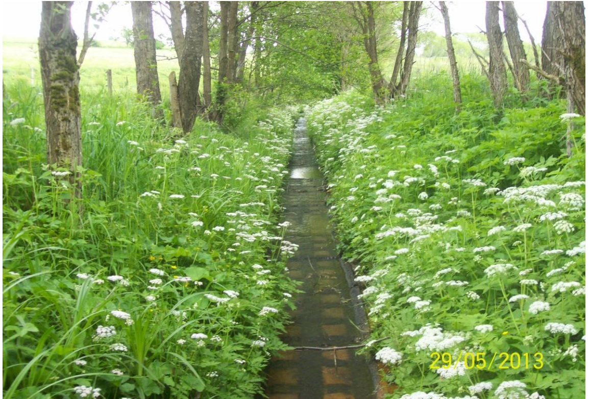
Obr. č. 36 – Napřímené koryto potoka – AUTOR PRÁCE 2013
