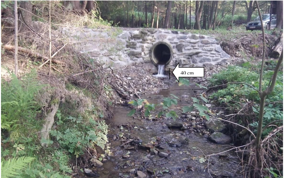
Obr. č. 73 – Nově opravený silniční propustek Všímarský – AUTOR PRÁCE 2013
