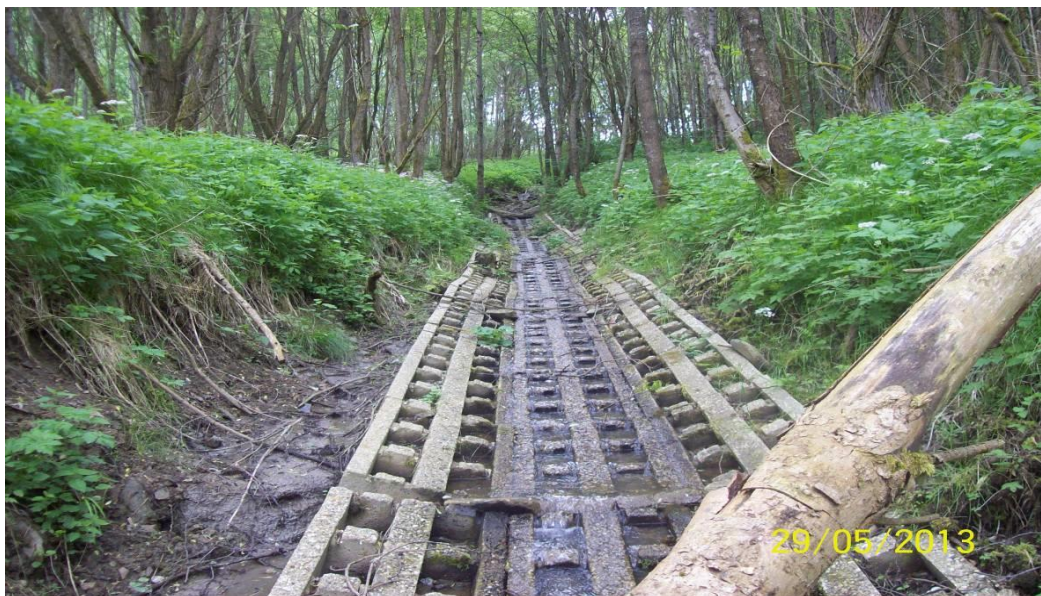
Obr. č. 41 – Prostřední část přítoku č.1 - AUTOR PRÁCE 2013
