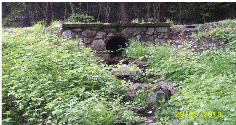
Obr. č. 64 – Silniční propustek přítoku č.3 - AUTOR PRÁCE 2013
