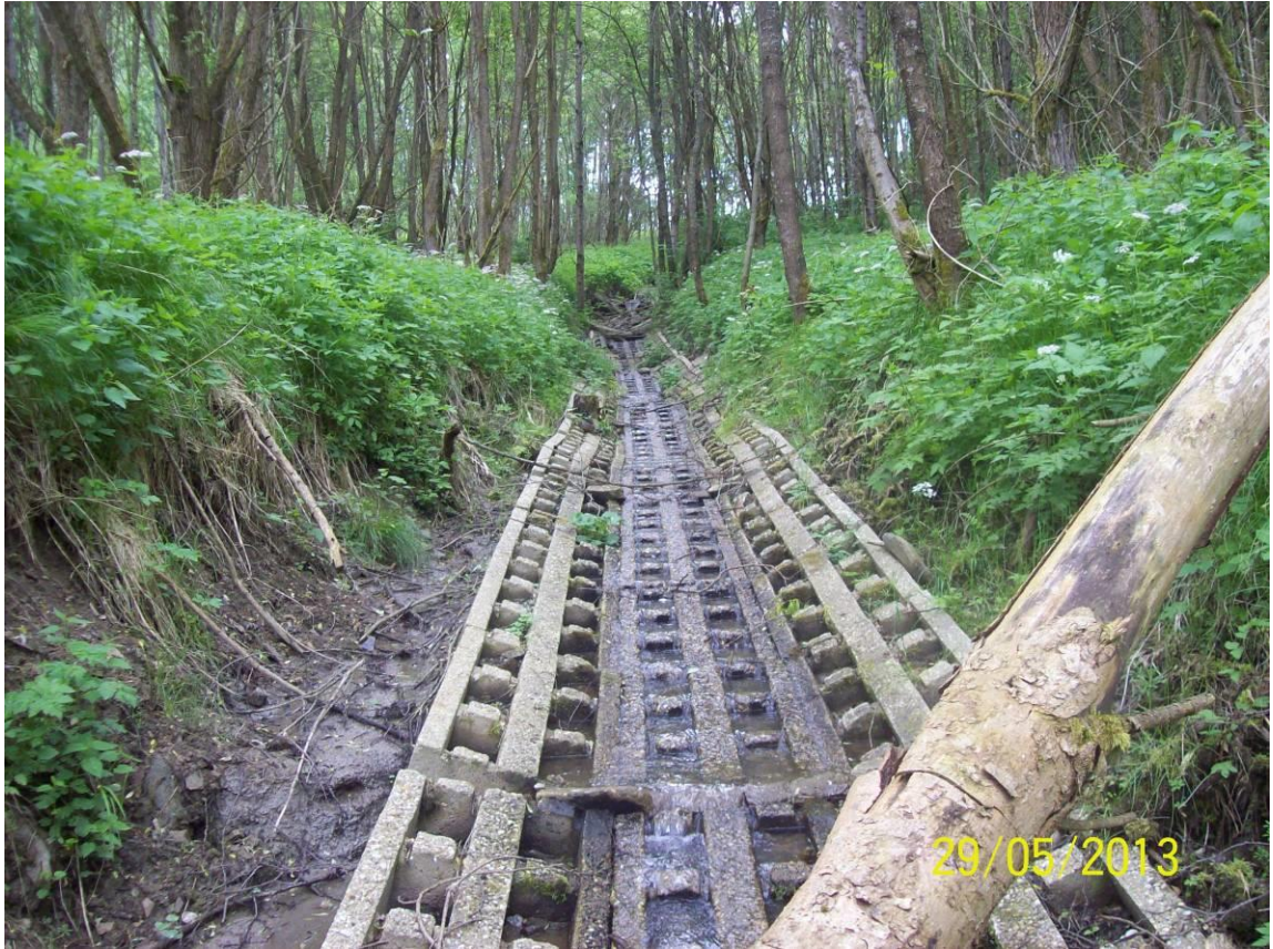
Obr. č. 23 – Napřímené meliorační koryto přítoku č. 1 do potoka Branná – AUTOR PRÁCE 2013
