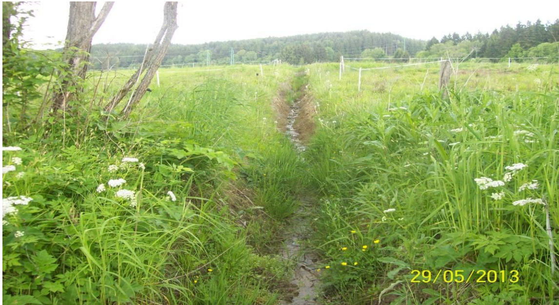
Obr. č. 50 – Odvodňovací kanál – pravá strana - AUTOR PRÁCE 2013
