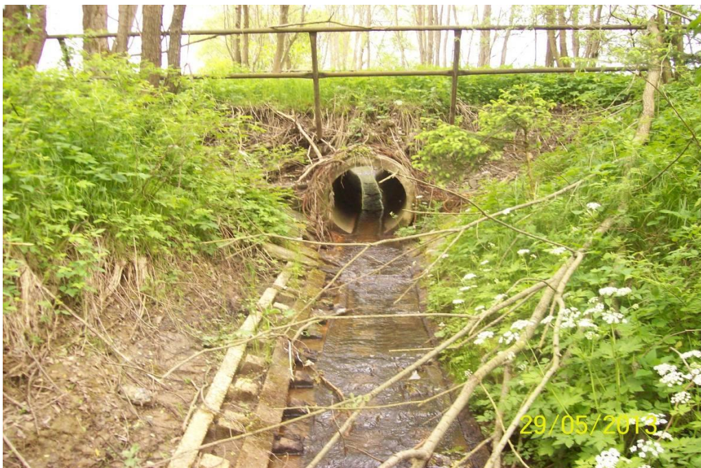
Obr. č. 40 – Propustek pod polní cestou – AUTOR PRÁCE 2013
