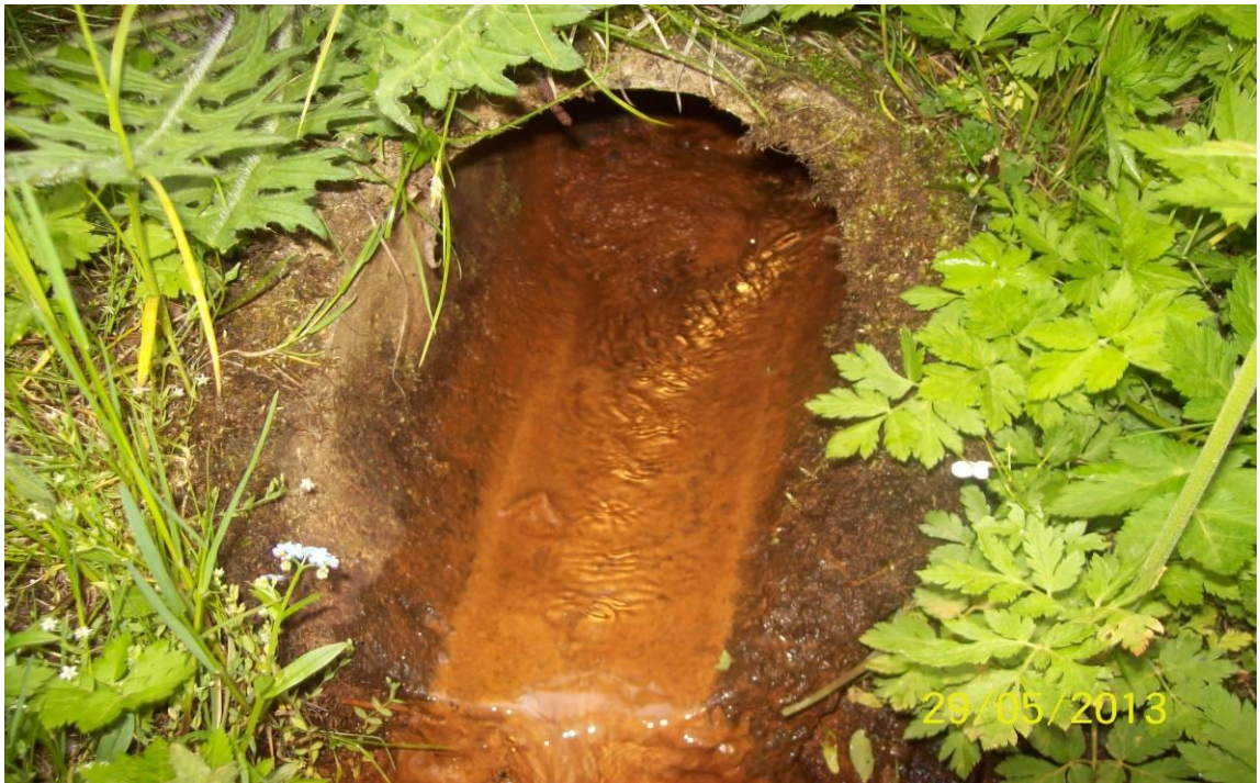
Obr. č. 46 – Vyústění sběrného drénu – provedení beton – AUTOR PRÁCE 2013
