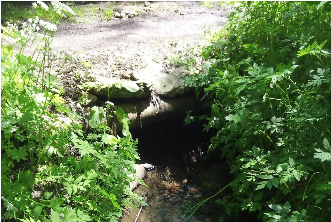
Obr. č. 70 – Komunikační propustek přítoku č. 6 v osadě Běleň – AUTOR PRÁCE 2013
