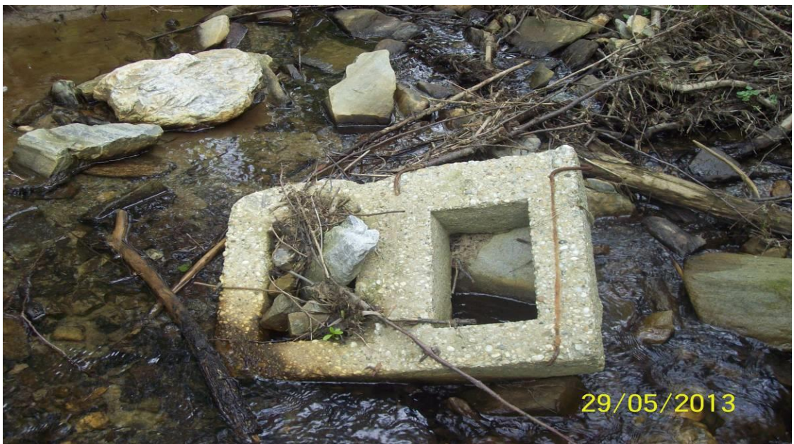
Obr. č. 79 – Zbytky polovegetačních tvárnic - AUTOR PRÁCE 2013
