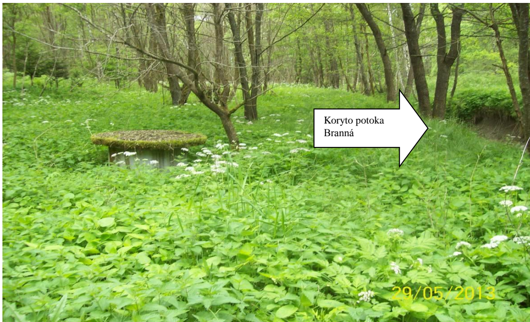
Obr. č. 48 – Betonová šachtice v lese – AUTOR PRÁCE 2013
