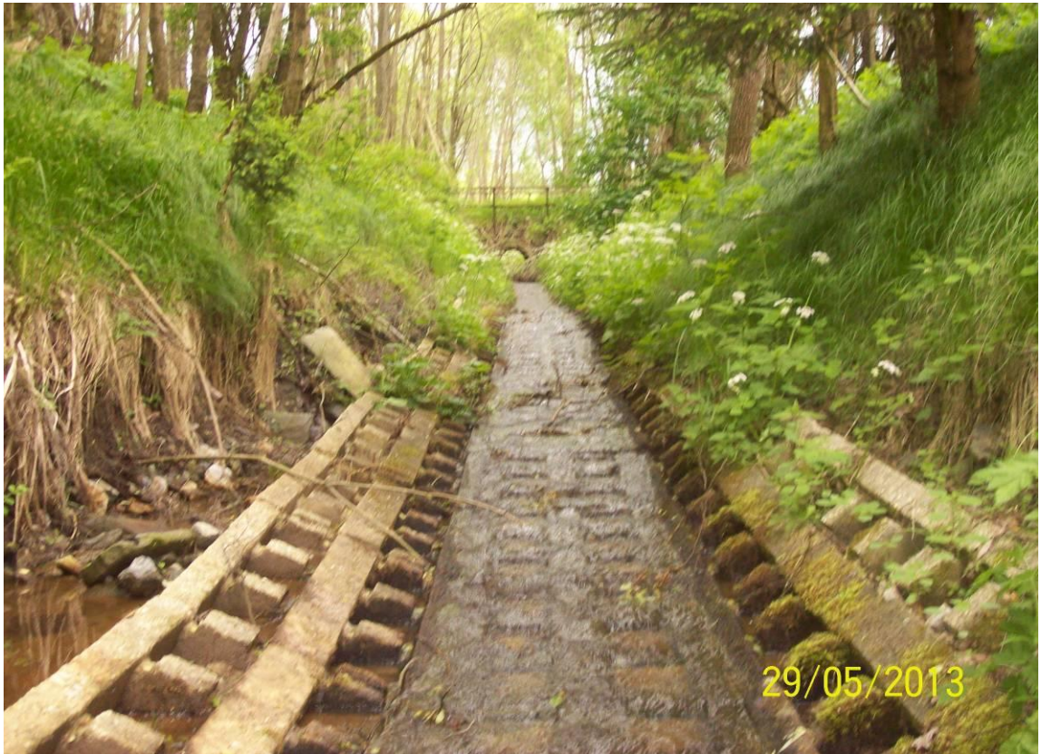
Obr. č. 22 – Meliorační zásah z betonových tvárnice – AUTOR PRÁCE 2013
