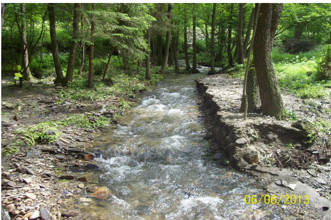
Obr. č. 4 – Nad cestou – 6. 6. 2013 po povodni – AUTOR PRÁCE
