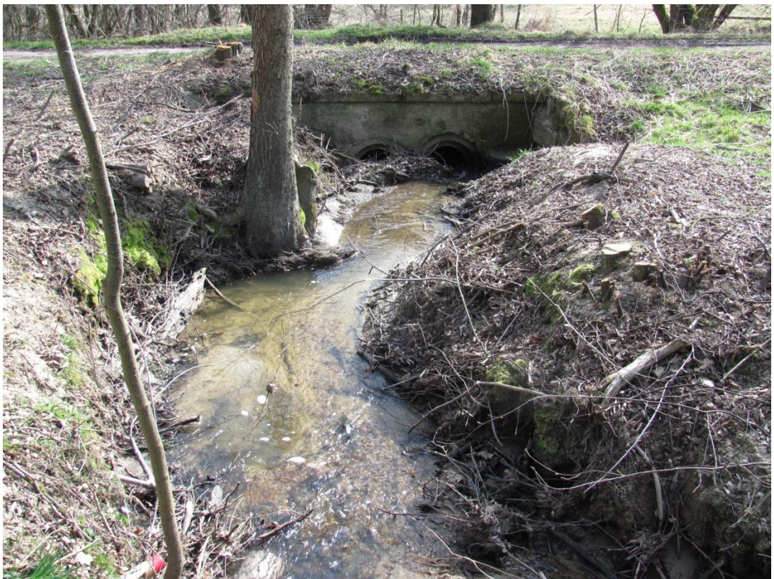
Příloha 7: Propust pod cestou.
