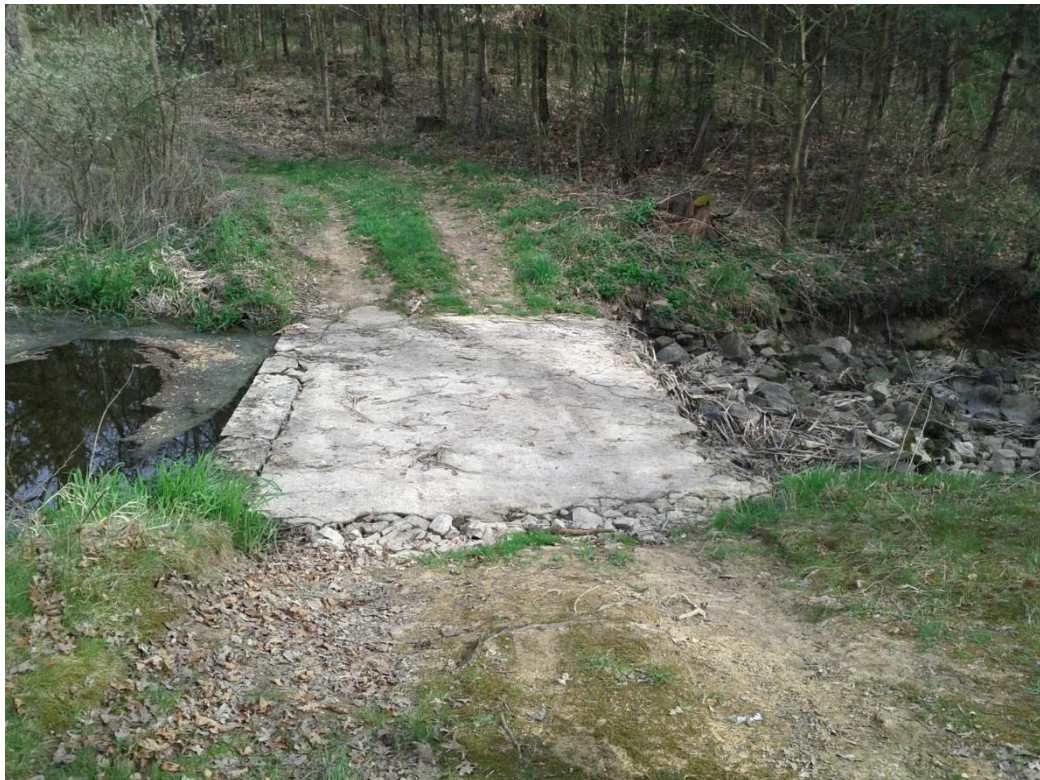
Foto č. 20 – Bezpečnostní přepad na hrázi Nového rybníka u Lišova
