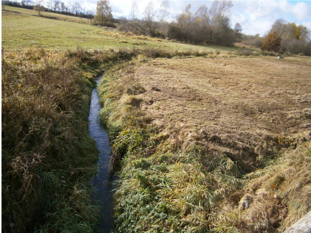
Foto č. 13 – Pohled na stav koryta Lišovského potoka na začátku 4. úseku
