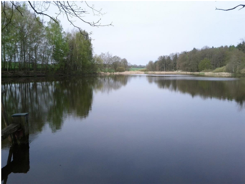
Foto č. 19 – Pohled na Nový rybník u Lišova z hráze
