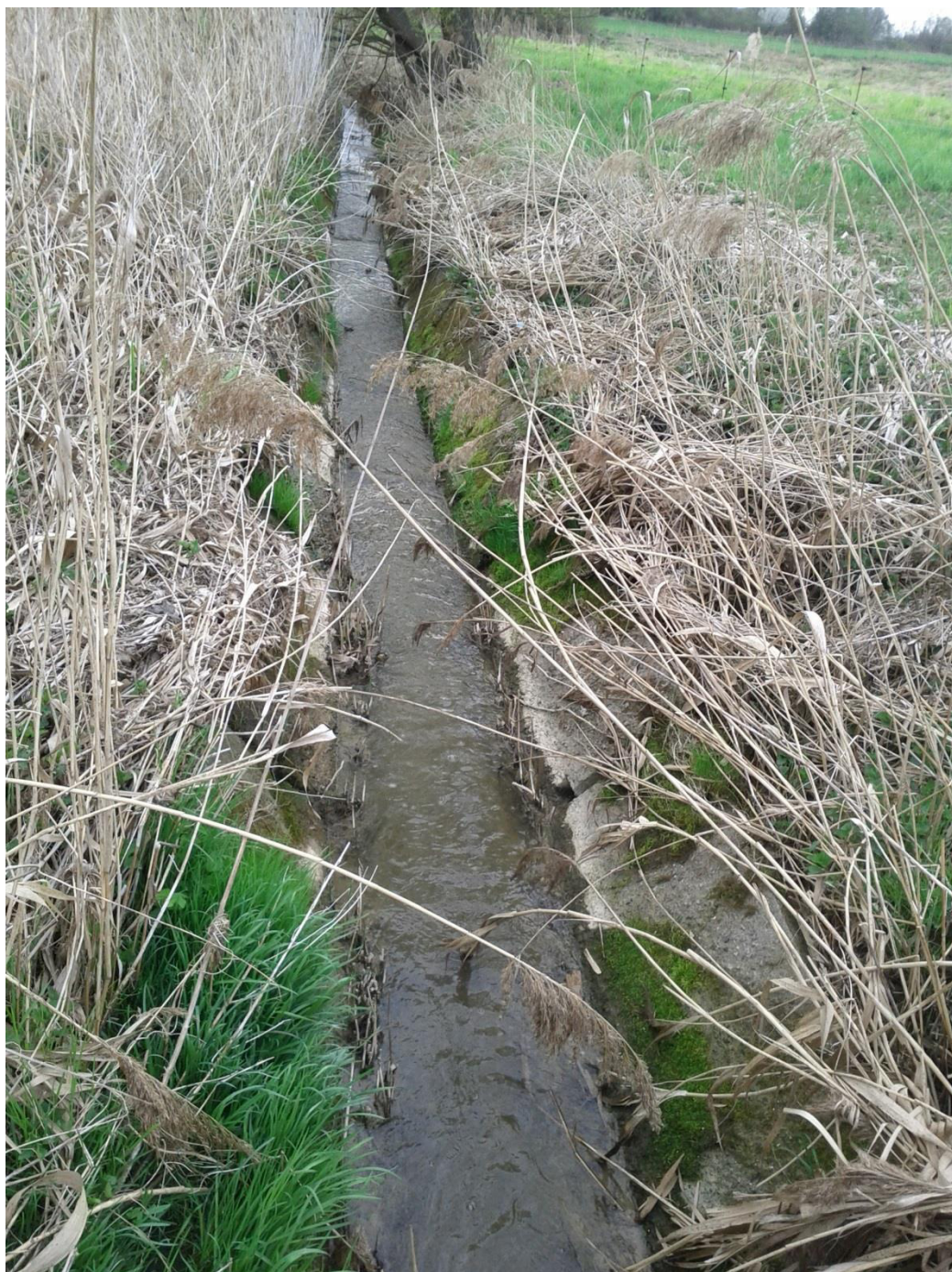
Foto č. 12 - Stav koryta Lišovského potoka ve 3. úseku pod soukromými zahradami (foceno směrem k 4. vymezenému úseku)
