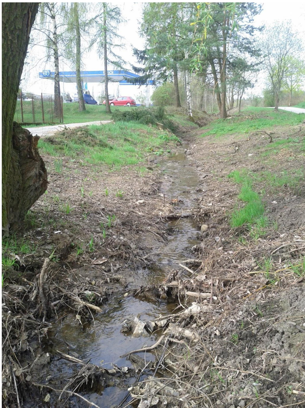
Foto č. 5 – Neupravené koryto toku ke konci 1. úseku na začátku města Lišov u benzínové stanice
