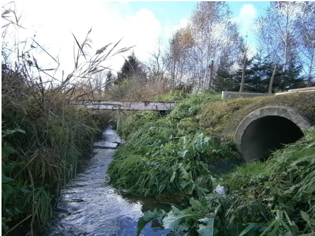
Foto č. 14 – Odvodňovací stoka ve 4. úseku pod městem Lišov
