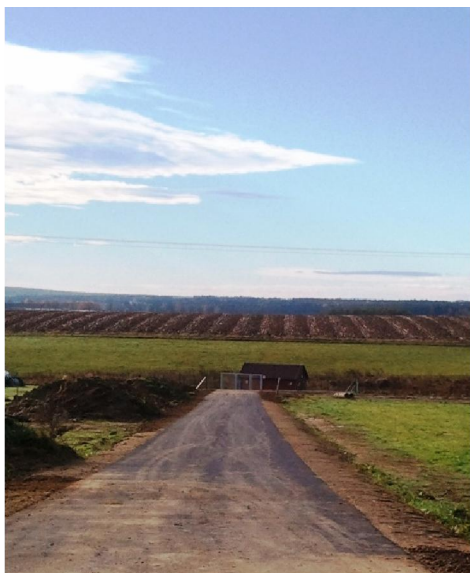
Obr. 7: pohled na C22 resp. D1, a ČOV, zdroj: vlastní
