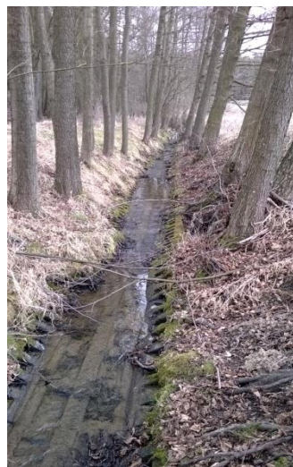
napřímený opevněný úsek, zdroj: Vlastní
