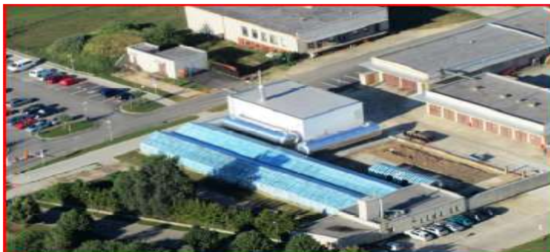
Obr. č. 14: Budova bioteplárny areál lázní Aurora (Zdroj: Kajan, 2011)
