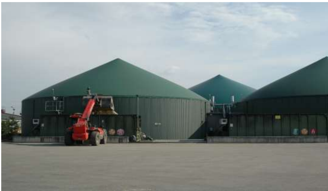
Obr. č. 19: Dávkovací zařízení na pevné substráty Kardašova Řečice (Zdroj: Zajíc, 2014)
