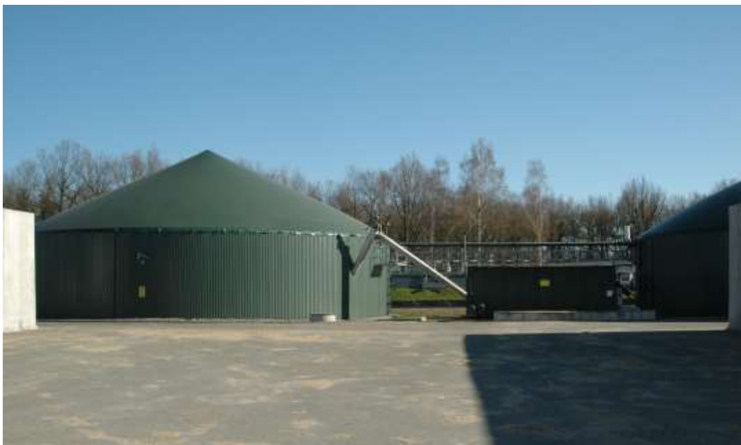
Obr. č. 8: Fermentor BPS Třeboň s dávkovacím zařízením (Zdroj: Zajíc, 2012)
