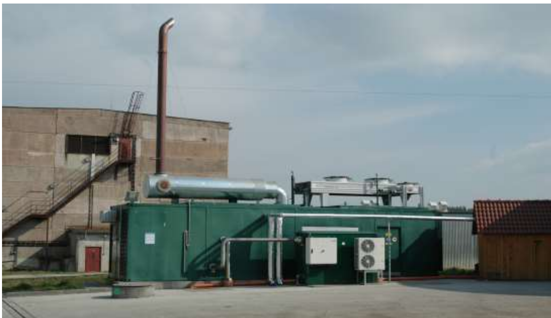
Obrázek č. 24 Kontejnerové kogenerace MWM (Zdroj: Zajíc, 2014)
