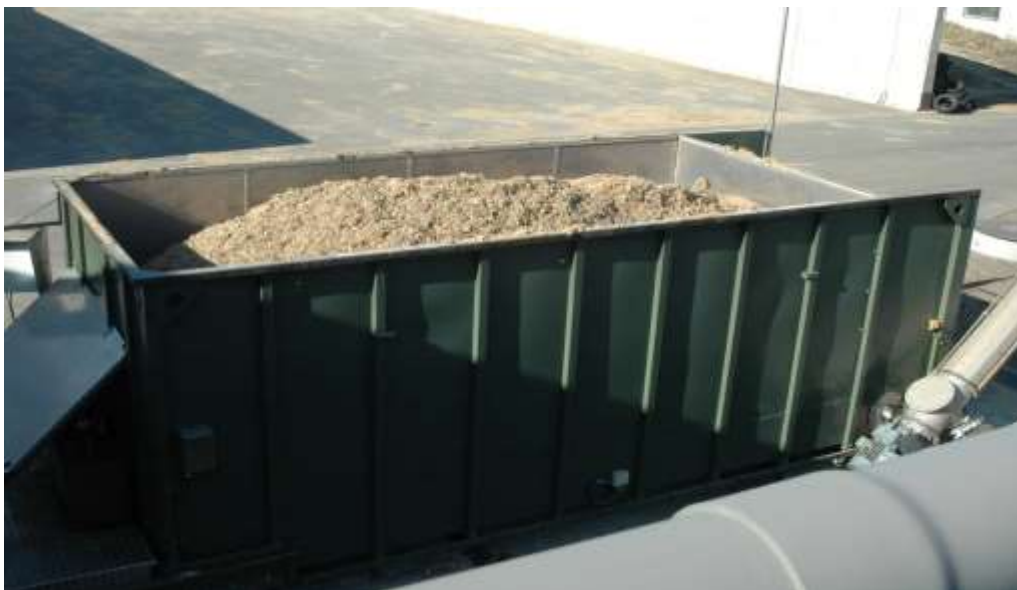
Obr. č. 10: Dávkovacími zařízení na pevné substráty BPS Třeboň pohled z fermentoru (Zdroj: Zajíc, 2012)
