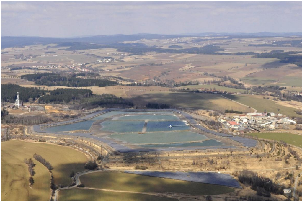
Foto 1: Odkaliště KI od jihu, vpravo chemická úpravna, vlevo areál jám R 2 a R 3 (interní archiv DIAMO, s. p., 2012 )
