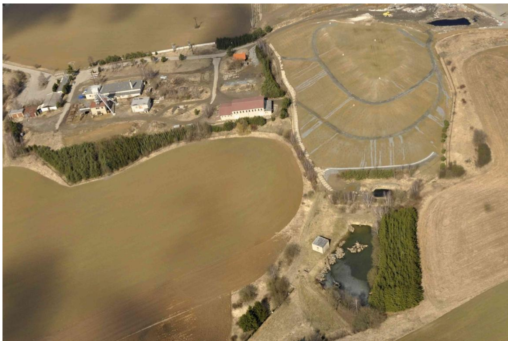
Foto 3: Areál Bukov 1, dnes na bývalém odvalu provozována skládka TKO (interní archiv DIAMO, s. p., 2012)
