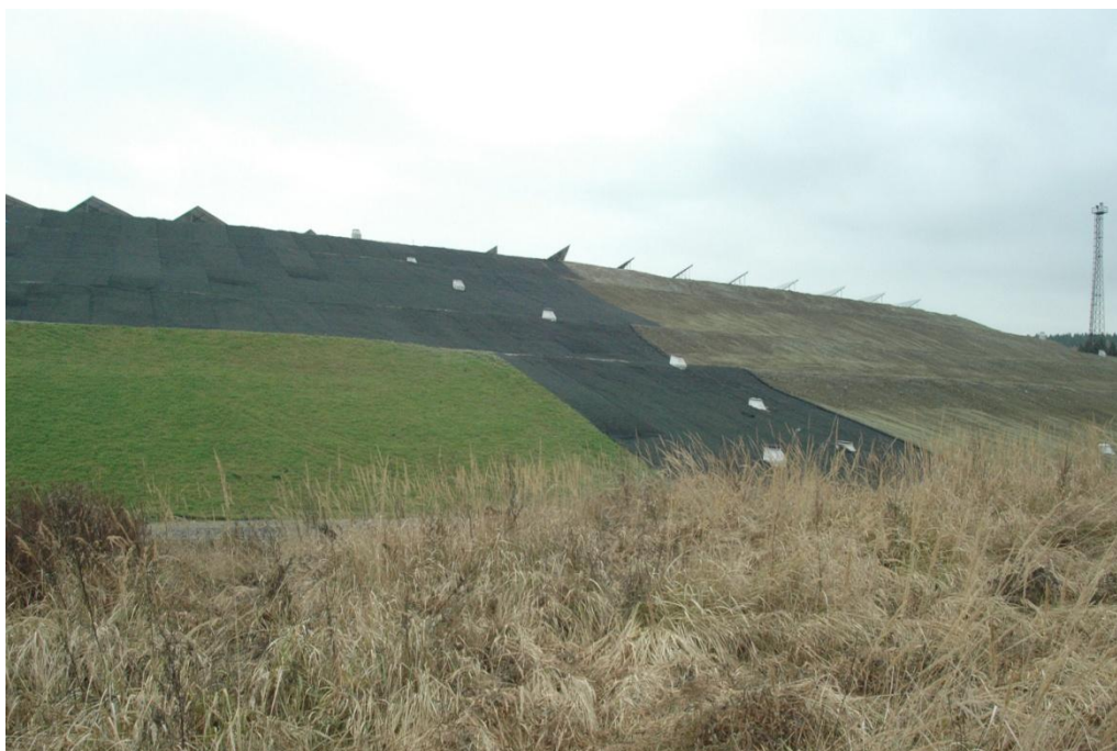
Foto 12: Sanace hráze odkaliště KI, uprostřed protierozní mřížka (2013), po okrajích ozeleněné vrstvy po rekultivaci z roku 2012 (interní archiv DIAMO, s. p., 2013)
