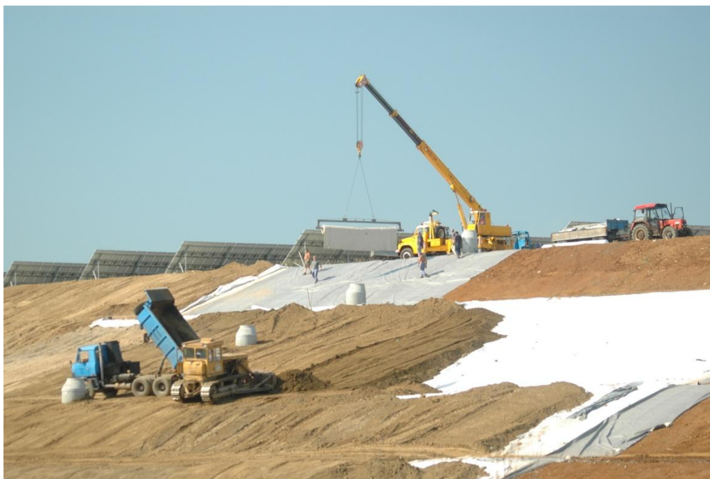
Foto 11: Sanace hráze odkaliště KI, pokládání těsnící rohože a vrstvy rekultivační zeminy (interní archiv DIAMO, s. p., 2012)
