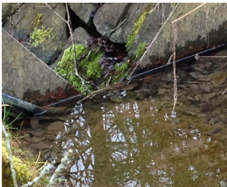
Obr. 12. – Zachycená větev v ostrohranném přepadu, Foto: Autor
