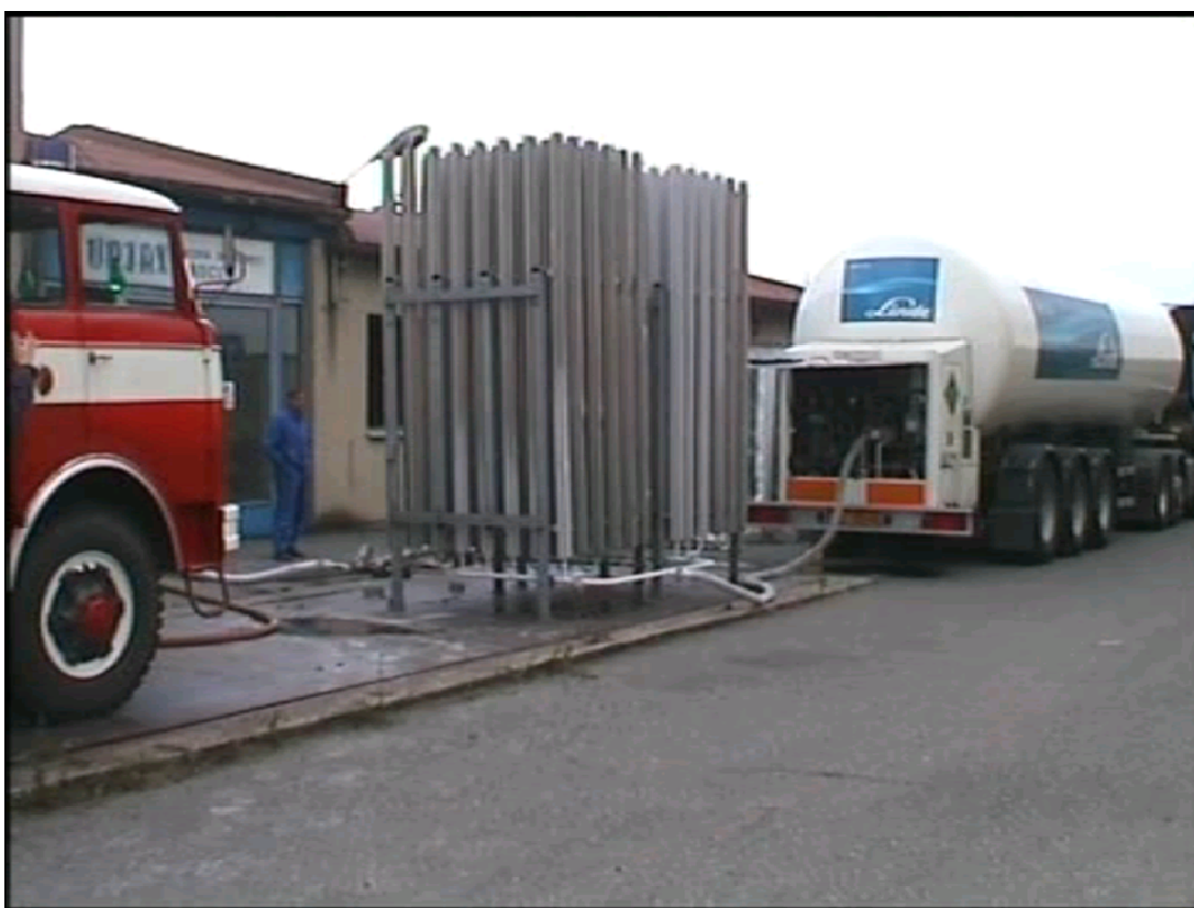
Obrázek 5: Zaplynování hal pomocí výměníku na kapalné CO 2
