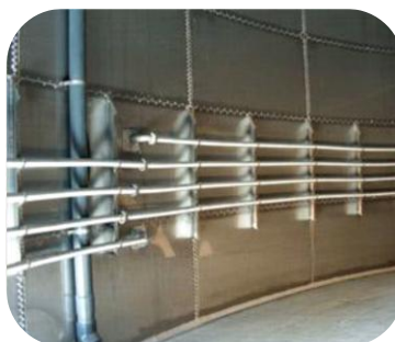
Obr. 5 Stěnové vytápění
