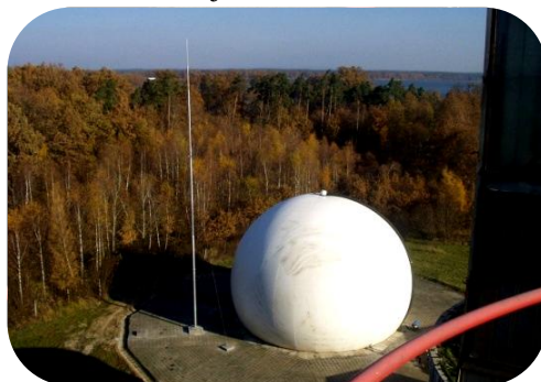
Obr. 6 Dvoumembránový Plynojem Sattler u bioplynové stanice v Třeboni o objemu 2100m 3 .
