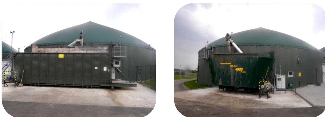
Obr. 16 Vkladače substrátu do fermentoru
