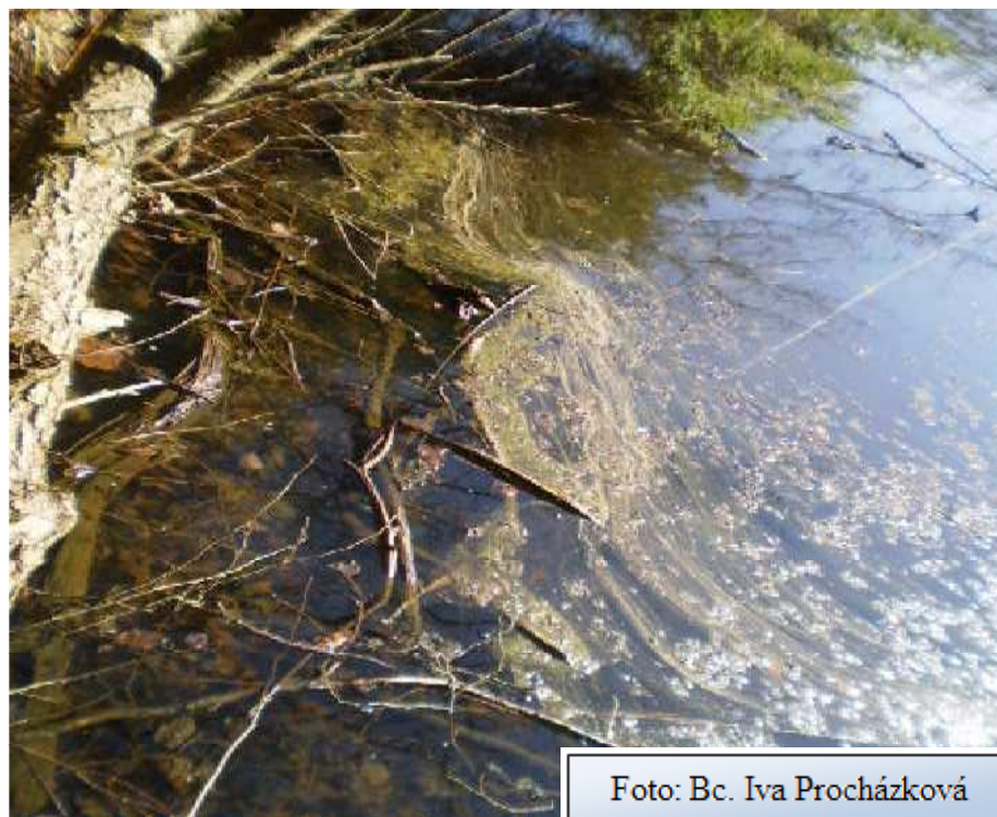
Foto č. 6 – Tvořící se zákal v blízkosti bezpečnostního přelivu
