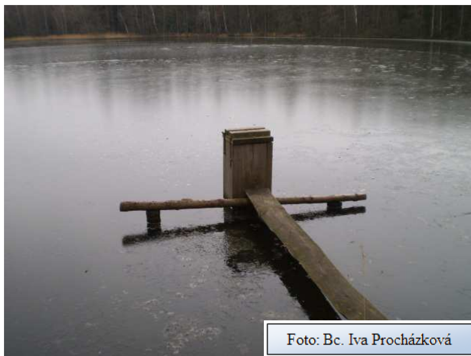
Foto č. 1 – Výpustné zařízení rybníku
