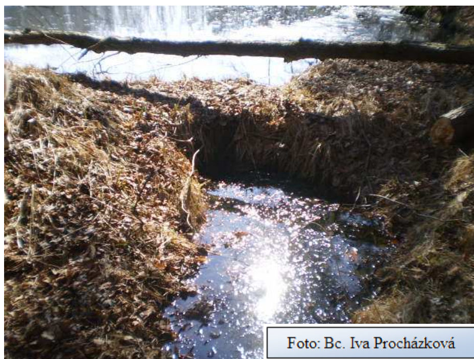
Foto č. 2 – Bezpečnostní přeliv s odpadním korytem
