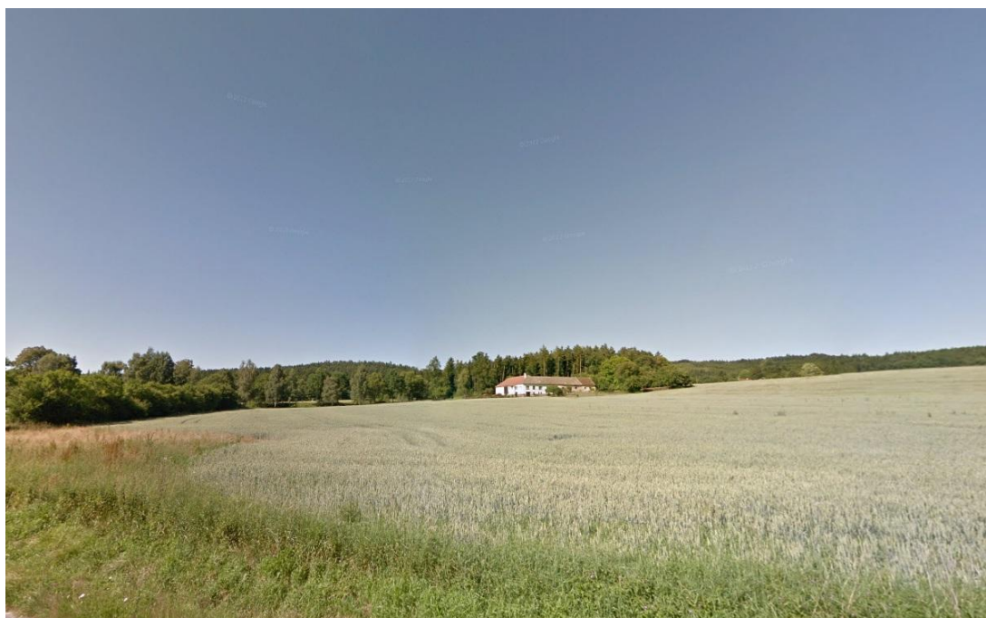
Obr. č. 32 Hospodářská usedlost (zdroj: vlastní)
