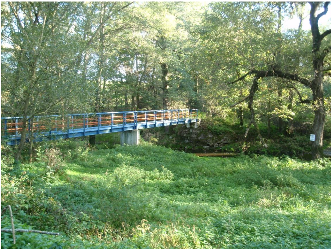
Obr. č. 26 Lávka přes řeku Blanici (zdroj: vlastní)
