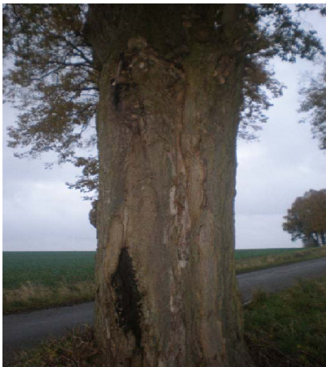
Obr. č. 7: Praskliny na kmeni
