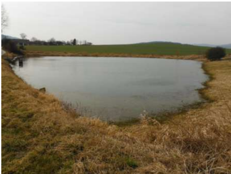
Obrázek 23 Realizace rekonstrukce vodní plochy (autor).
