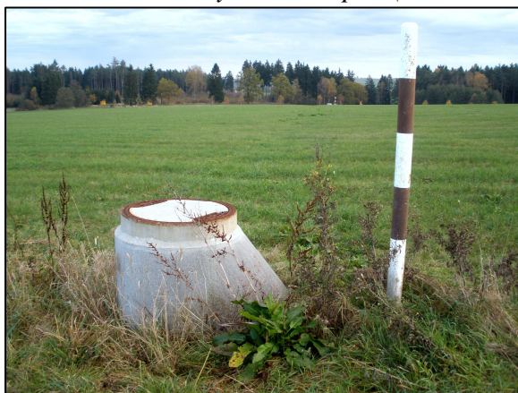
Foto 5: Realizovaný trubní odpad (k.ú. Sudoměřice u Tábora)
