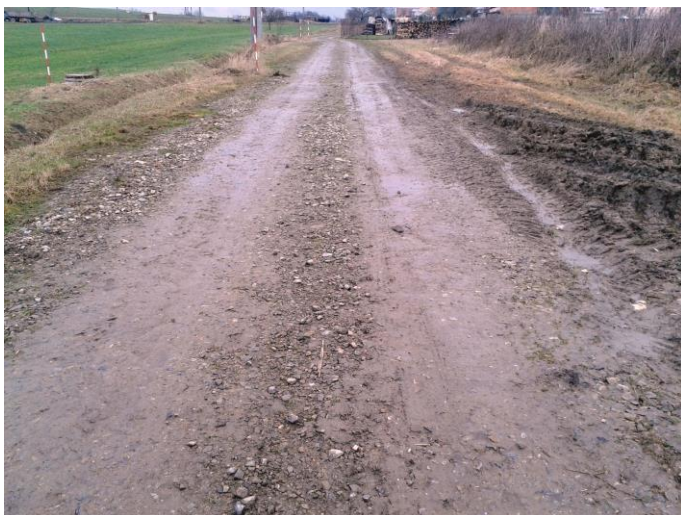
Foto č. 9: C7 – příjezd k ČOV, po rekonstrukci, 800 m, štěrk
