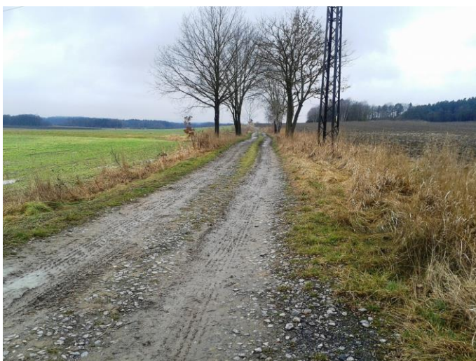
Foto č. 2: C9 – odbočka ze silnice III/14110, návrh rekonstrukce, asphalt, ozelenění dle plánu ÚSES
