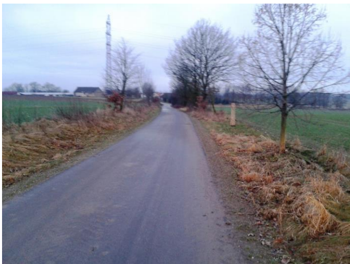
Foto č. 7: C6 – 600 m od intravilánu po rekonstrukci, asfalt, výsadba oboustranné liniové zeleně
