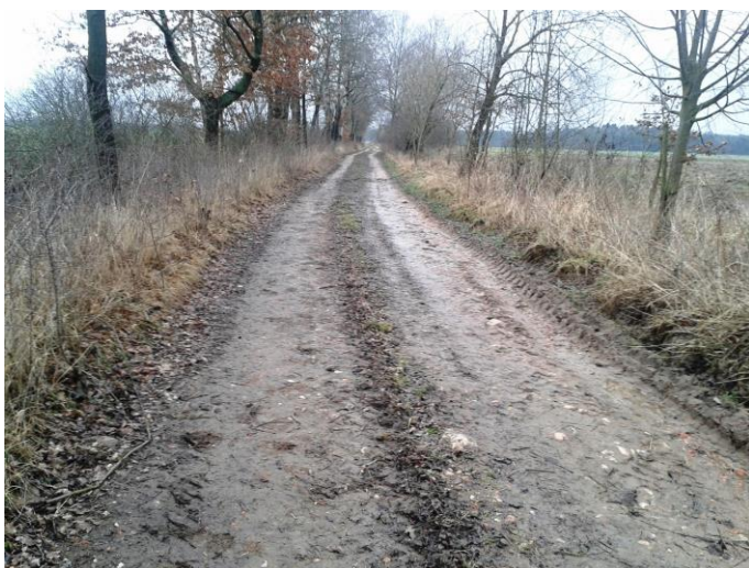
Foto č. 8: C6 – navazujících 820 m, po rekonstrukci, štěrk, oboustranná liniová zeleň (stromy, keře)
