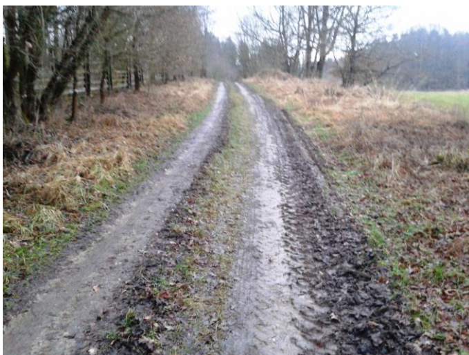
Foto č. 6: C5 – stav po rekonstrukci, travnatý povrch, částečná liniová zeleň
