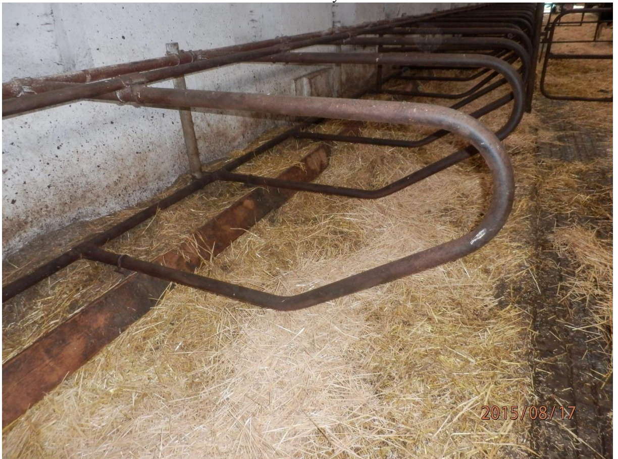
Obrázek 14: Nedostatečně dimenzované lehací boxy
