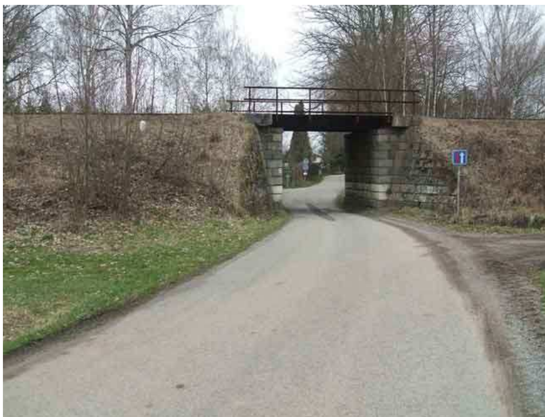
Zastavení č. 2 – Železniční viadukt
