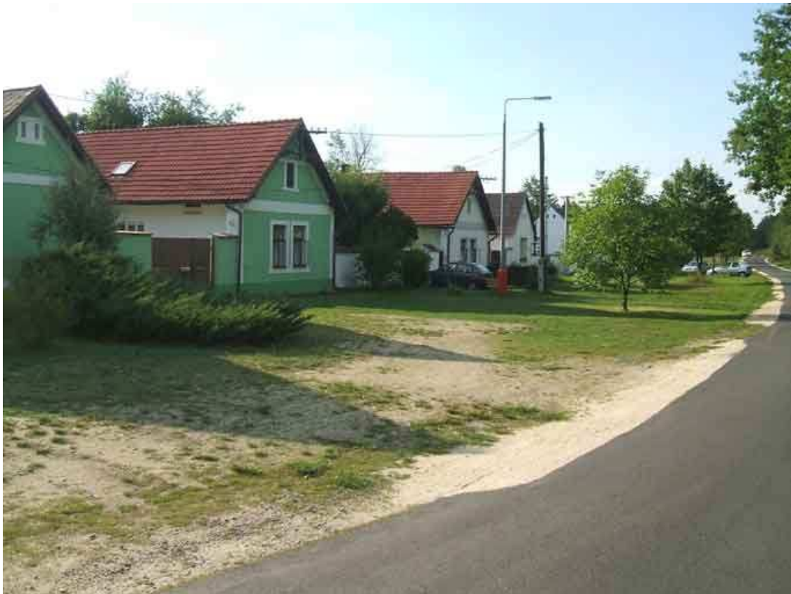
Zastavení č. 15 – Kozí vrch – naproti tradiční vesnické zástavbě
