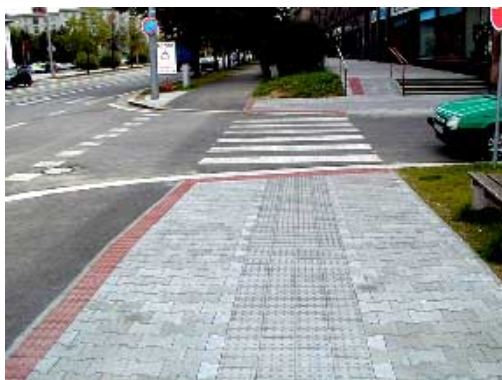
Obrázek č. 5 - správně provedený signální a varovný pás
