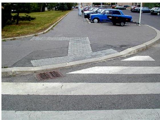
Obrázek č. 6 - správně provedený signální a varovný pás
