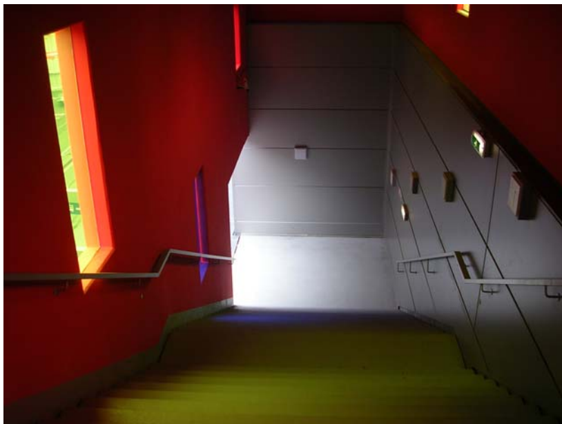
Obrázek č. 19 - nevhodně osvětlení na schodišti
