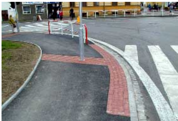
Obrázek č. 4 - správně provedený signální a varovný pás
