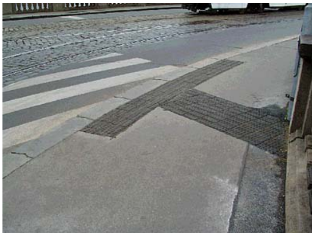
Obrázek č. 7 - správně provedený signální a varovný pás
