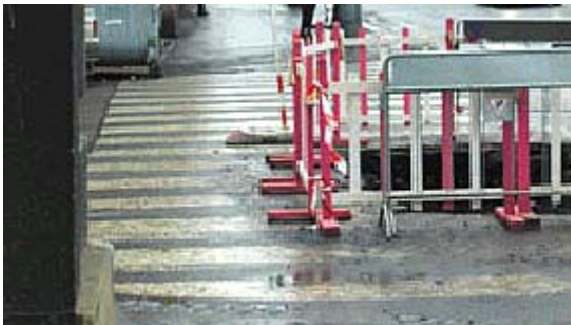
Obrázek č. 13 - zajištěné výkopové práce na komunikaci
