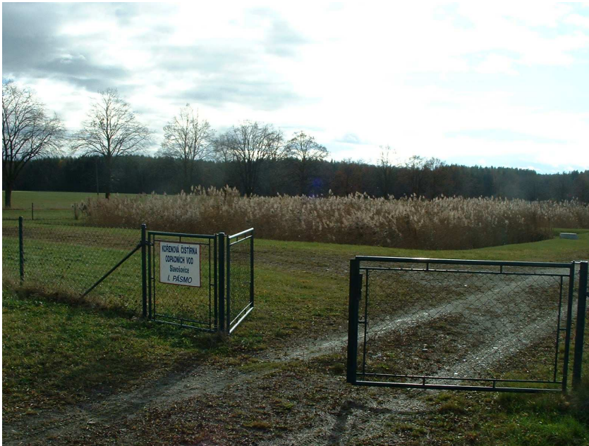
Fotografie 1: Kořenová čistírna odpadních vod Slavošovice (14.11.2006)
