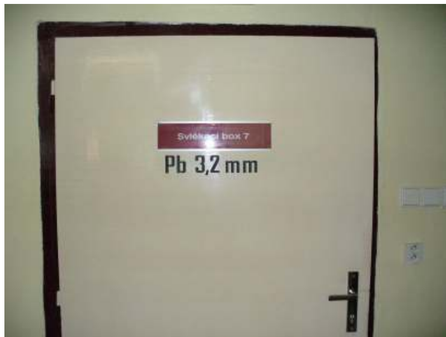
Příloha č. 7 Ochranné dveře s Pb vložkou. (foto: Miloš Řehák, duben 07, 2007)
