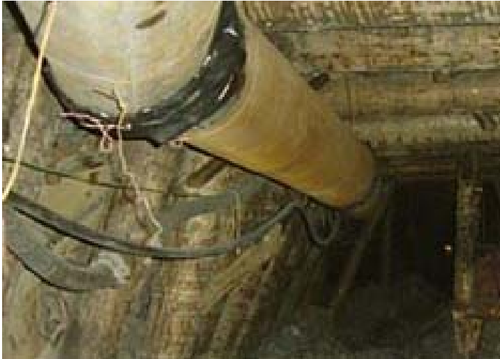
Obr.3. důlní chodba s lutnovým větráním
