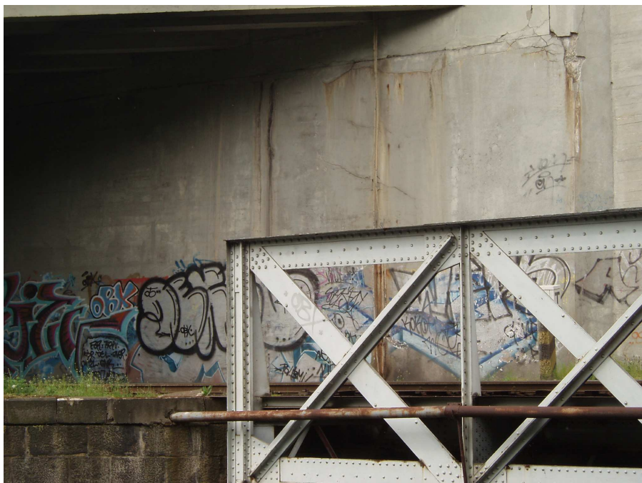
Zdroj: fotodokumentace autora – železniční trať mezi Horním a Dolním nádražím v Karlových Varech;
