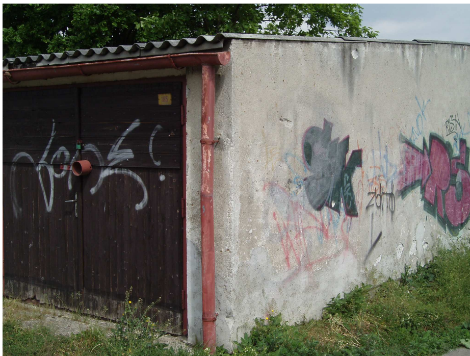
Zdroj: fotodokumentace autora, Karlovy Vary – Tuhnice, garáže;
