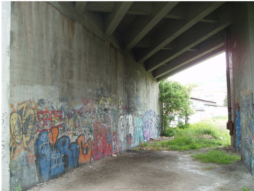
Zdroj: fotodokumentace autora, Karlovy Vary – železniční trať mezi Horním a Dolním nádražím;
