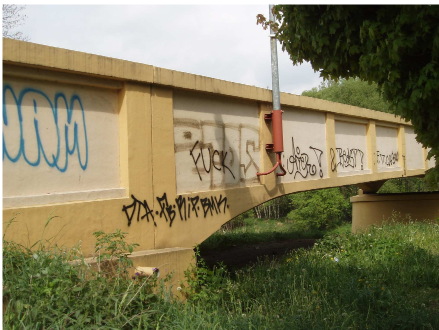
Zdroj: fotodokumentace autora, Karlovy Vary – Tuhnická lávka;
