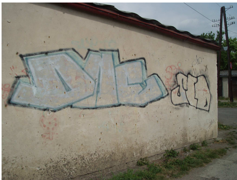
Zdroj: fotodokumentace autora, Karlovy Vary – Tuhnice- garáže;
