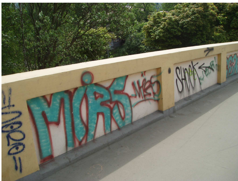
Zdroj: fotodokumentace autora, Karlovy Vary – Tuhnická lávka;
