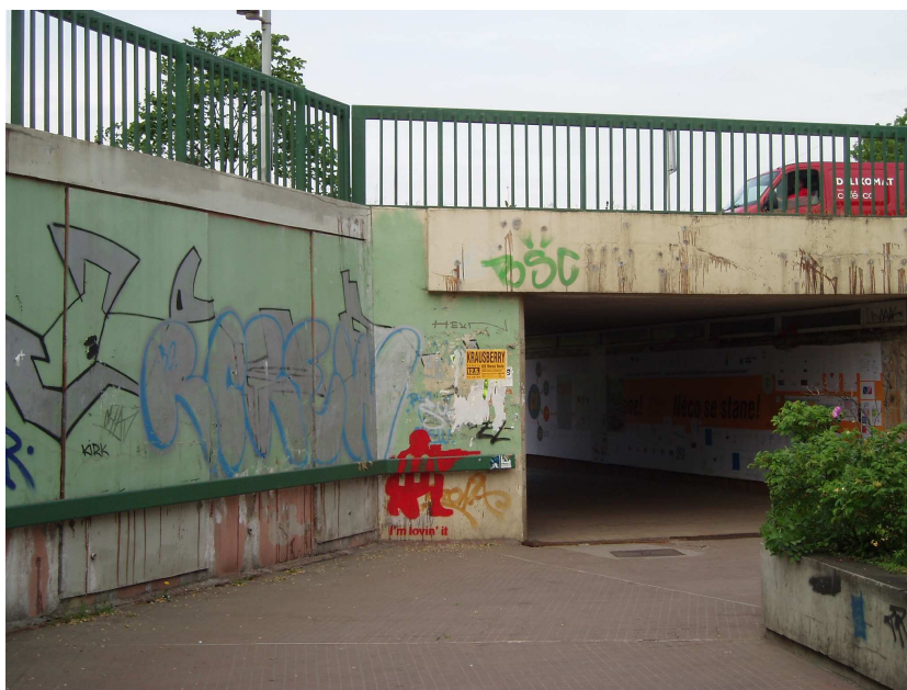
Zdroj: fotodokumentace autora, Karlovy Vary – centrum – podchod;
