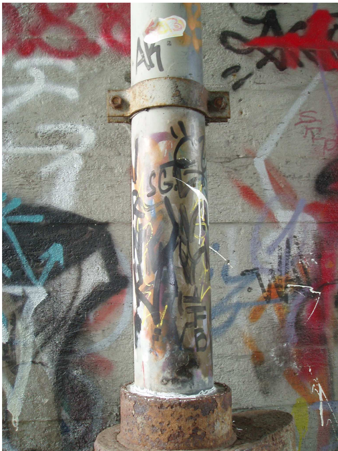
Zdroj: fotodokumentace autora, Karlovy Vary – železniční trať mezi Dolním a Horním nádražím;
