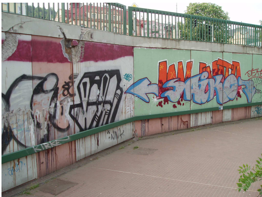
Zdroj: fotodokumentace autora, Karlovy Vary – centrum, podchod;
