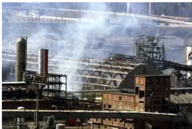
Obrázek č. 35: Skladiště dusičnanu amonného
