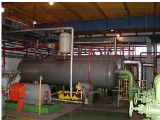
Obr č.40: Strojovna chlazení na zimním stadiónu a potrubí s amoniakem pod ledovou plochou zimního stadiónu
