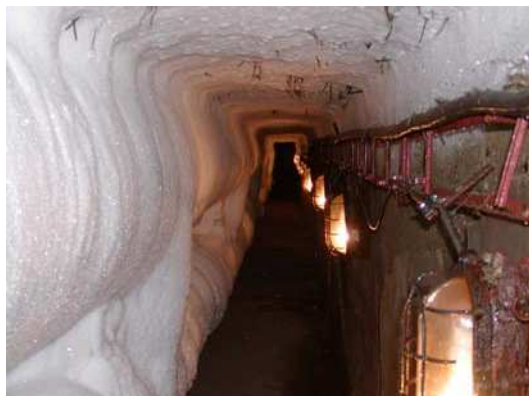
Obr č.40: Strojovna chlazení na zimním stadiónu a potrubí s amoniakem pod ledovou plochou zimního stadiónu
