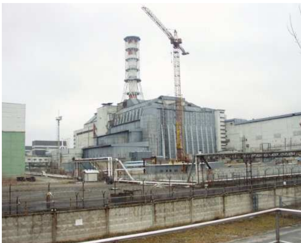
Obr. č. 6: Sarkofág - betonová obálka s vestavěným chladicím systémem (49)
