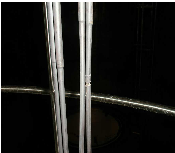
Obr. 4.8 Poškozené čidlo MNT.
