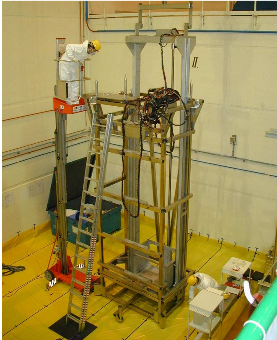
Obr. 4.7 Pohled na MSIO při nácviu montáže probíhající mimo reaktorový sál v BAPP 1.
