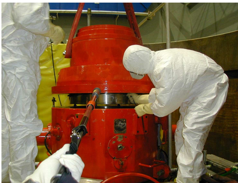
Obr. 4.16 Dekontaminace vnitřních částí navíjedla čidel MNT.
