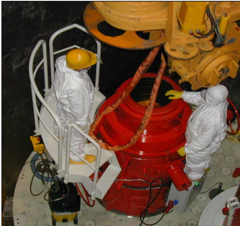
Obr. 4.9 Celkový pohled na zařízení pro vyjímání čidel MNT ustavené na plošině BOT.
