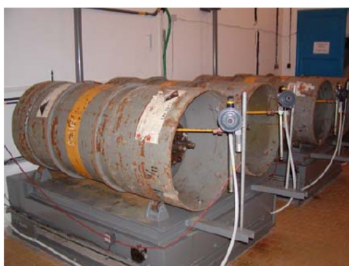
Foto č.3: Chlorovací stanice v úpravně vod
