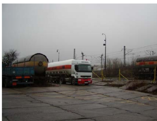
Foto č.4: Přečerpávání LPG z železniční cisterny do autocisterny
