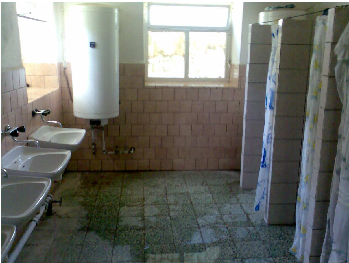
Obrázek č. 3.-pohled do umývárny
