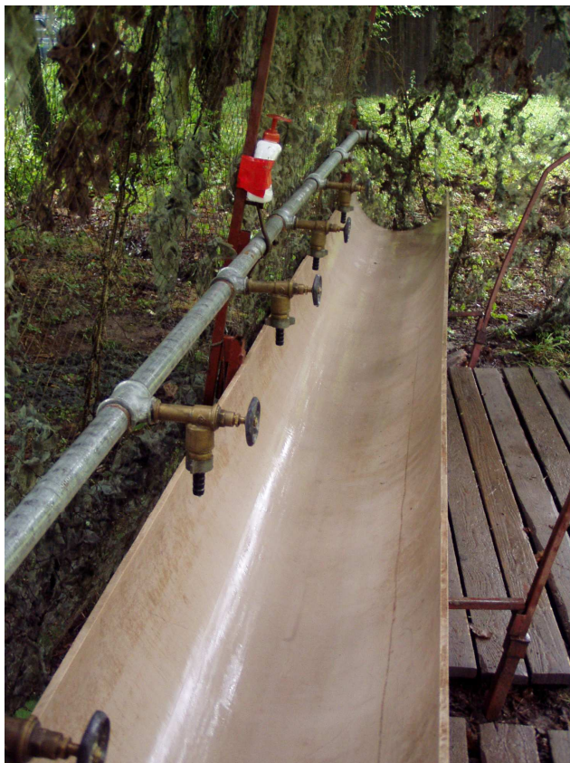
Obr.1 mycí žlab s výtakovými kohouty
